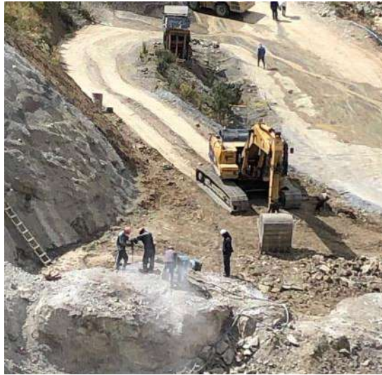
Excavación común y retiro de material para la banquina 3677.00 – 3670.00
