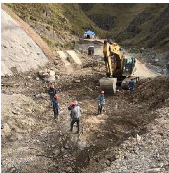
Excavación de roca por voladura ejes 10-11
