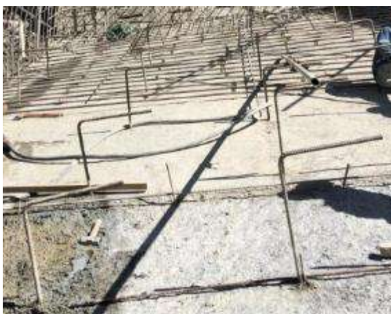
Instalación de barras de anclaje entre los ejes 9-10
