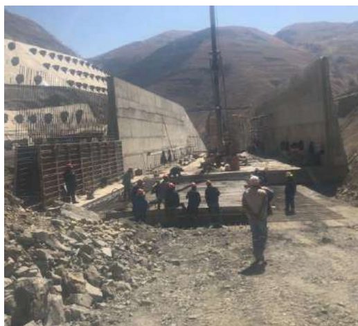
Hormigonado del muro para el canal del vertedero entre las cotas 3763.91– 3765.19 entre los ejes 5-6 y 9-10
