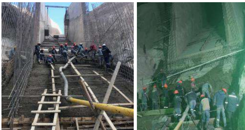
Hormigonado del muro para el canal del vertedero entre las cotas 3685,17-3688,7 entre los 9-10
