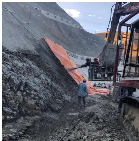
Lanzado de hormigón entre cotas 3768.65-3774.37
