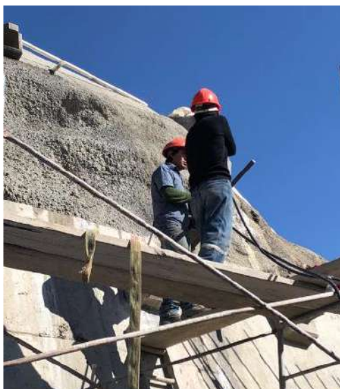
Pruebas de Carga de recibimiento y tesado de barras cota 3772.00
