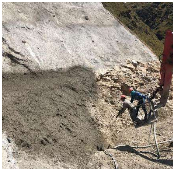
Proyectado de hormigón en el talud de la pantalla 3678,00 -3672,00
