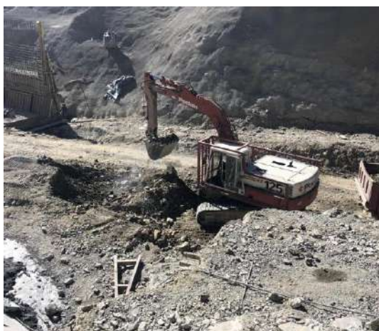
Excavación común y retiro de material para la pantalla atirantada y el canal del vertedero
