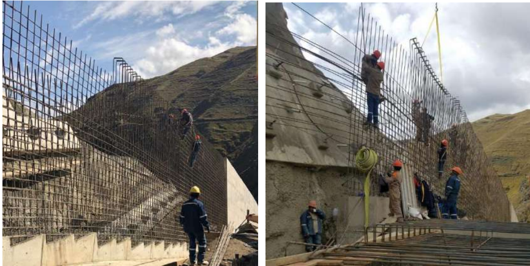
Colocado de acero para el canal del vertedero eje 5-6
