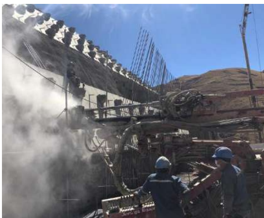
Colocado de drenes DHP'S en la cota 3765.00
