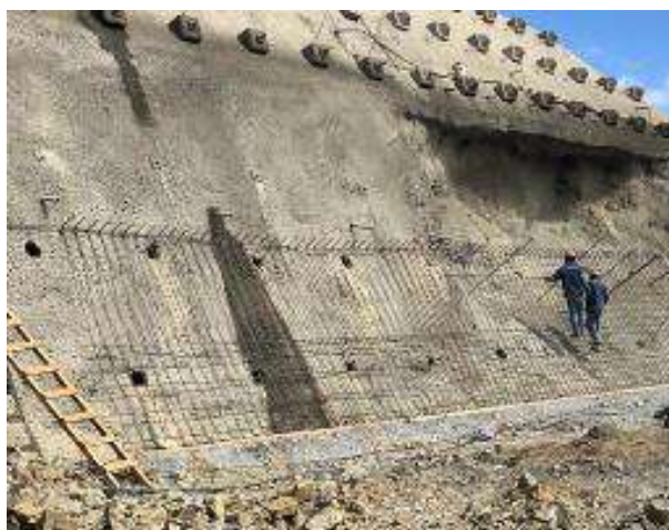
Colocado de lloraderos en cota 3765.50
