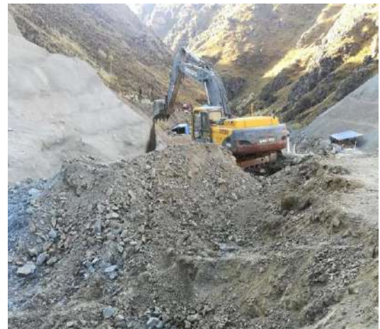
Excavación común y retiro de material para la banquina 3683.00-3665.26
