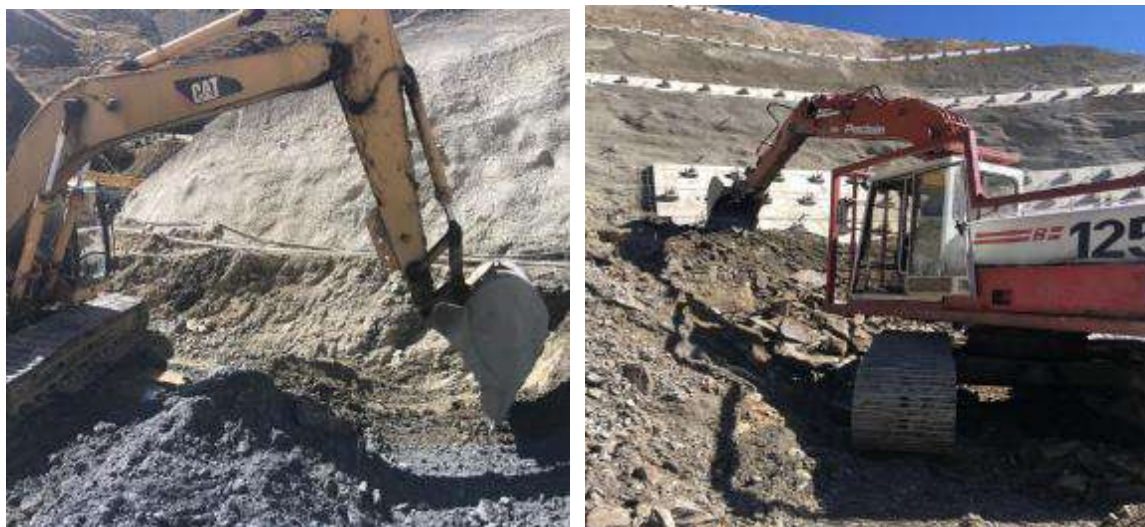
Excavación común y retiro de material para la pantalla atirantada 3767.50 y el canal del vertedero
