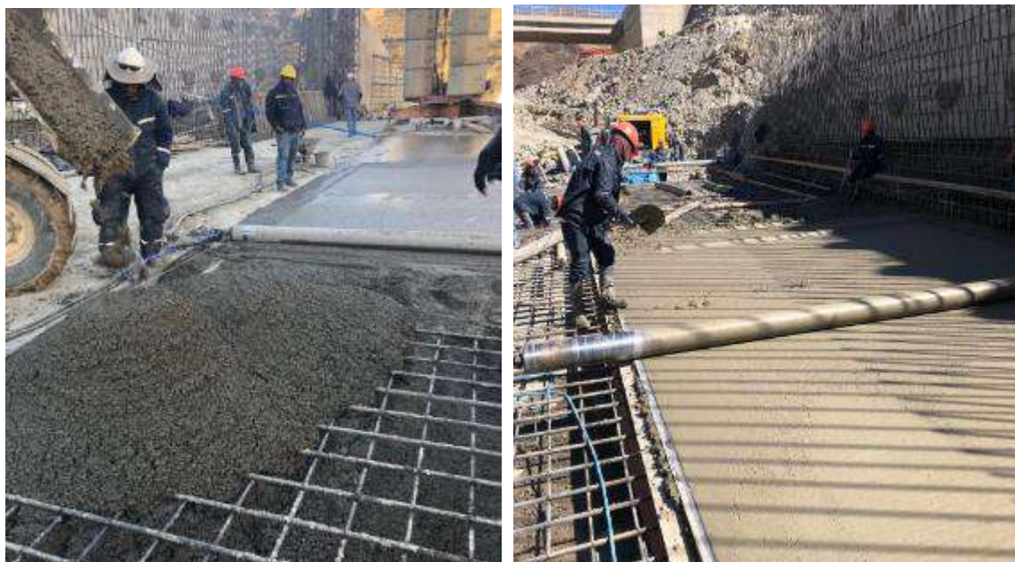
Hormigonado para la losa del canal del vertedero entre los ejes 4-5.
