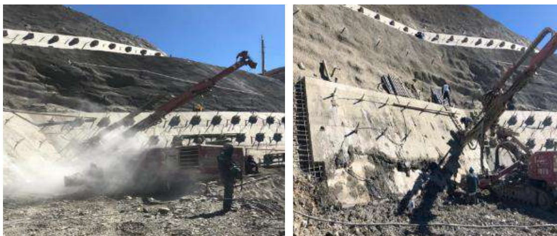
Perforación de barras Williams cota 3772.00 paño 7
