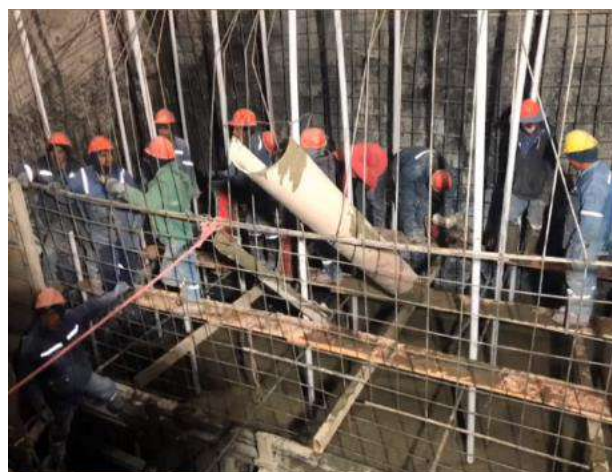
Hormigonado del muro para el canal del vertedero entre las cotas 3763.91– 3765.19 entre los ejes 5-6 y 9-10
