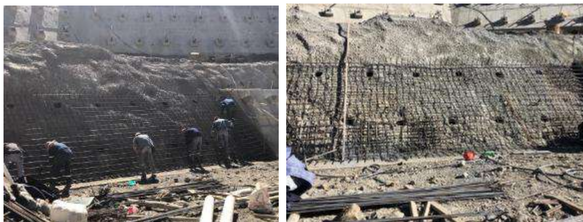
Colocado de acero de refuerzo para la pantalla atirantada 3767.50
