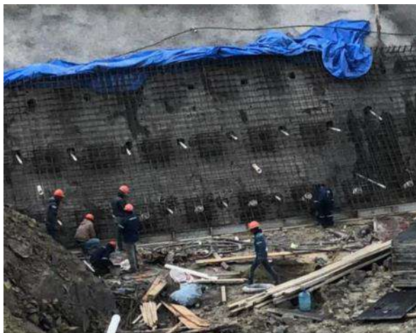
Colocado de lloraderos en cota 3772.00
