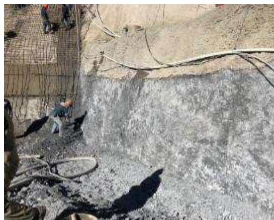
Proyectado de hormigón en el talud de la pantalla 3684.92-3668.92
