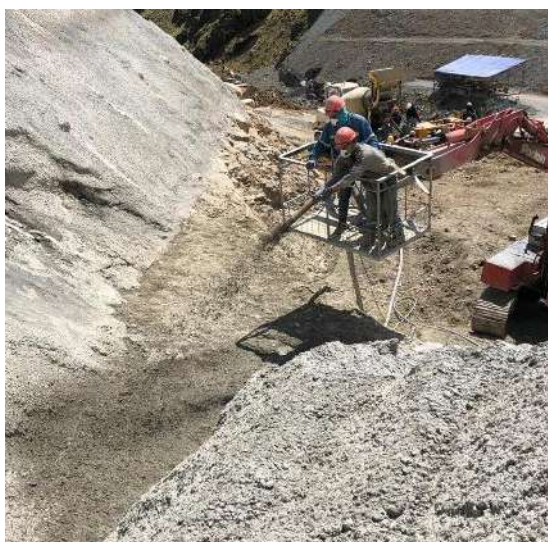
Proyectado de hormigón en el talud de la pantalla 3678,00 -3672,00
