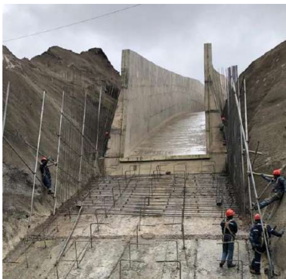
Colocado de acero para el canal del vertedero cota 3687.00 eje 9-10
