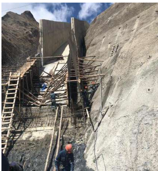
Colocado de hormigón tipo O para el vertedero en la cota 3697.05 – 3698.
