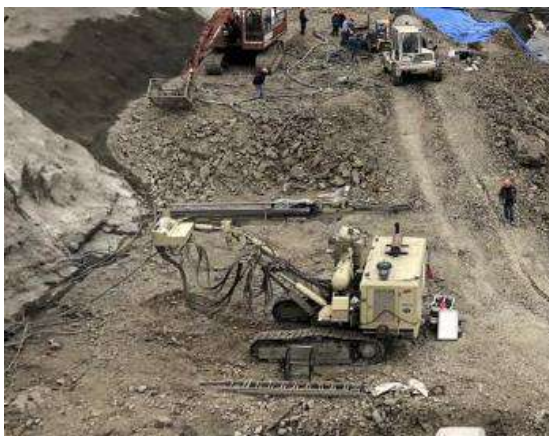
Perforación de DHP en la pantalla de cota 3772.00
