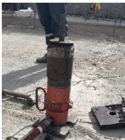
Pruebas de carga para las barras de anclaje para el canal del vertedero entre los ejes 4-5
