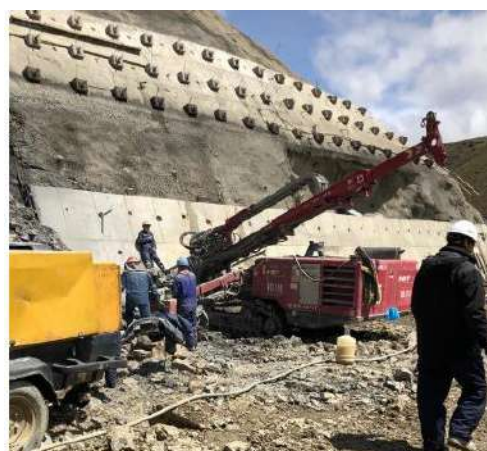
Perforación en la pantalla atirantada 3765.50
