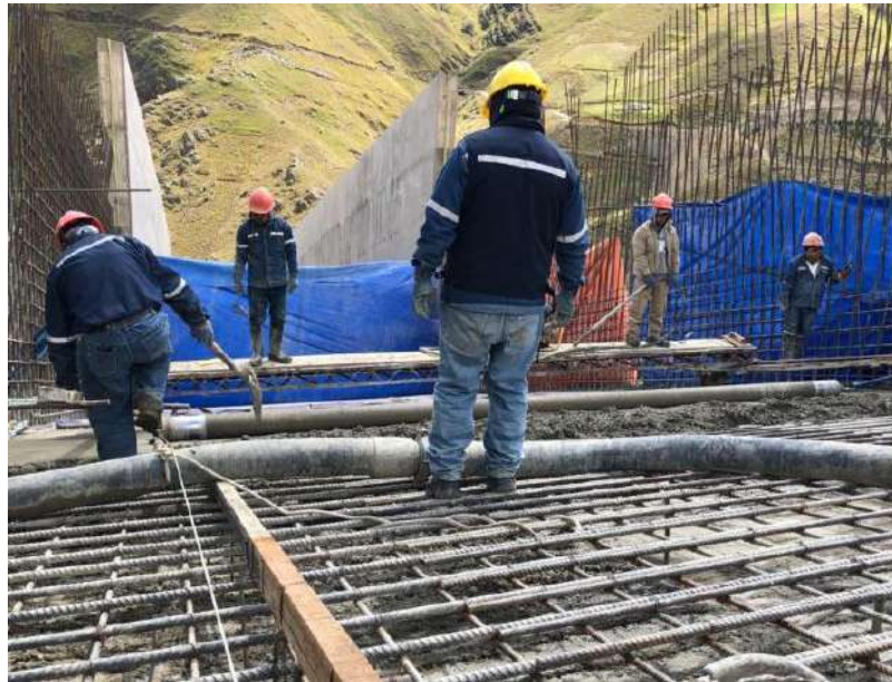
Colocado de acero para el canal del vertedero ejes 5-6
