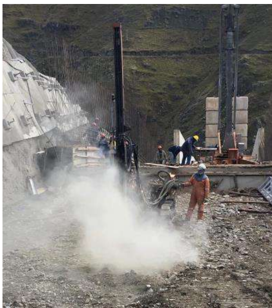
Perforación de barras de anclaje entre los ejes 4-6
