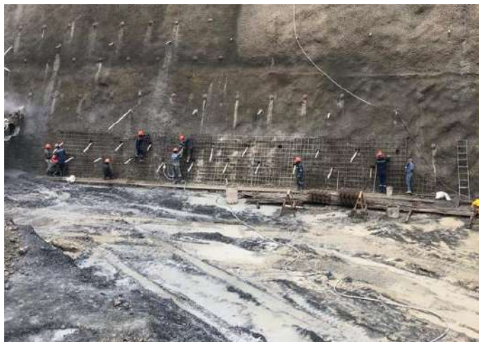
Colocado de acero para la pantalla atirantada cota 3675.00
