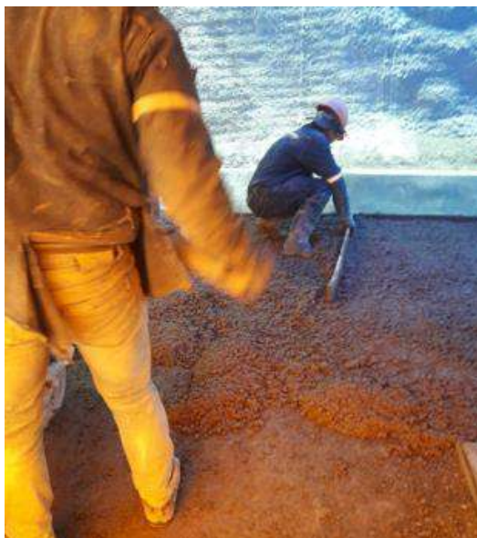
Hormigonado de la banquina cotas 3695.00
