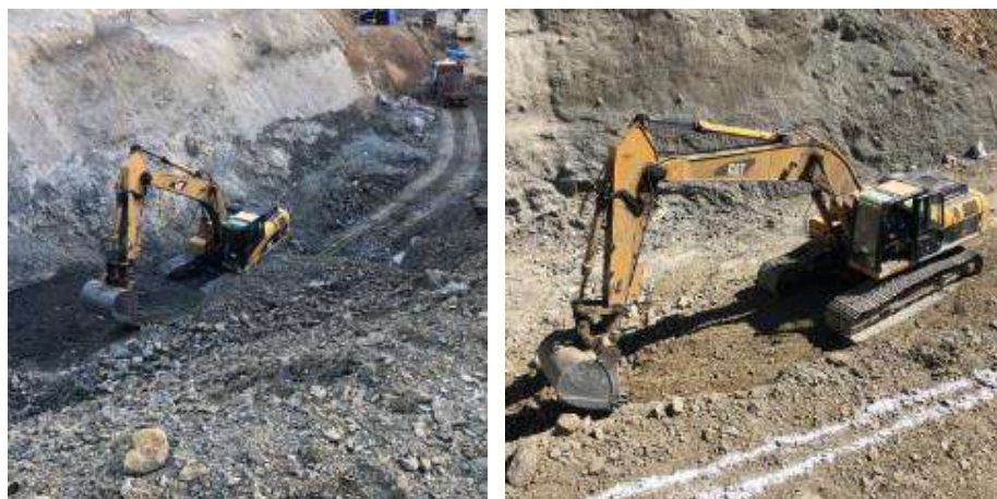
Excavación común y retiro de material para la banquina 3683.00-3665.26
