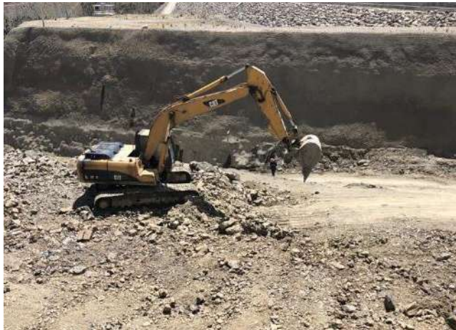
Excavación común y retiro de material para la banquina 3772.00 – 3767.00
