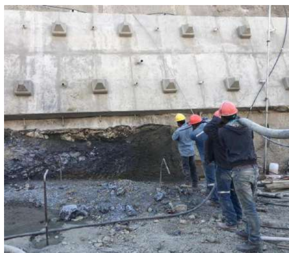
Lanzado de hormigón entre cotas 3769,00-3763,97
