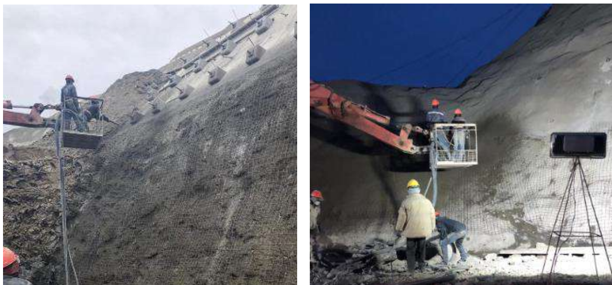
Proyectado de hormigón en el talud de la pantalla 3782.00 – 3775.00
