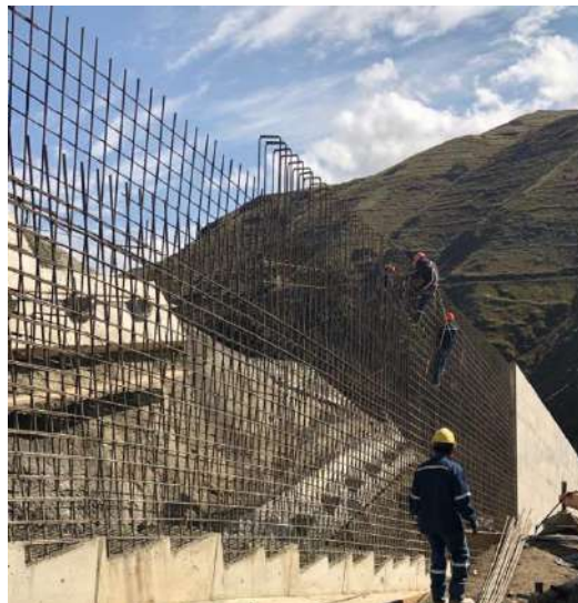
Colocado de acero para el canal del vertedero cota 3687.00 eje 5-6
