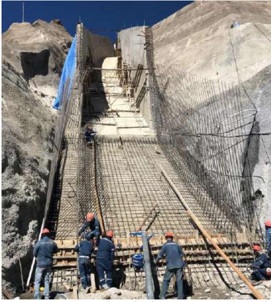
Colocado de acero para el canal del vertedero entre los ejes 9-10
