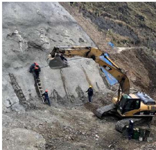
Perforaciones pernos A1 en el talud entre cotas 3675,00-3670,00
