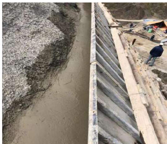
Hormigonado de la pantalla atirantada en cota 3772.00
