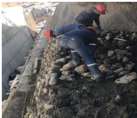
Relleno con mampostería de piedra cota 3772.00
