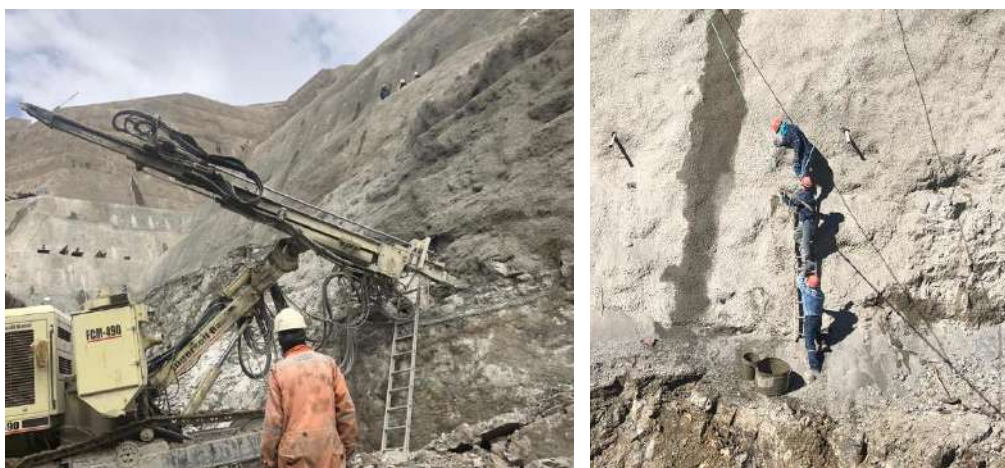
Perforaciones pernos A1 en el talud entre cotas 3675.00 – 3673.00
