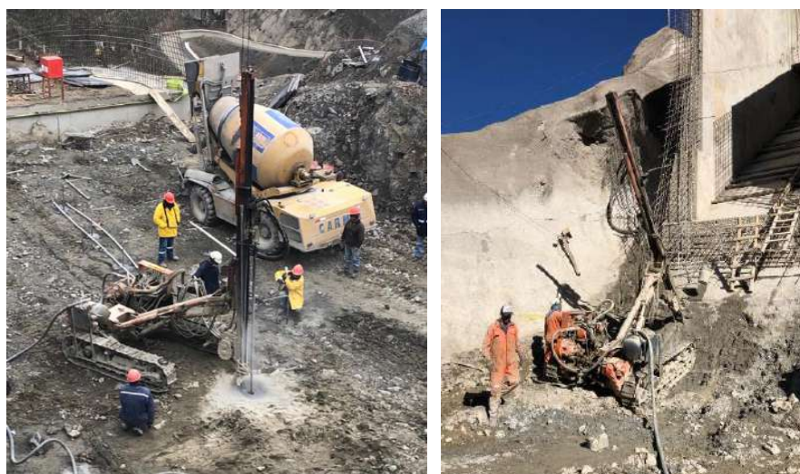
Perforación de barras de anclaje entre los ejes 4-5 y 9-10
