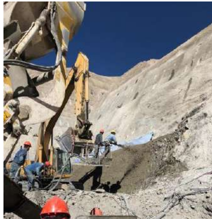
Proyectado de hormigón en el talud de la pantalla 3685,00 -3668.00
