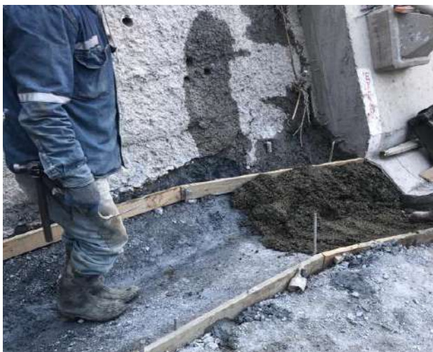
Hormigonado de la cuneta revestida con concreto simple entre cotas 3675.00
