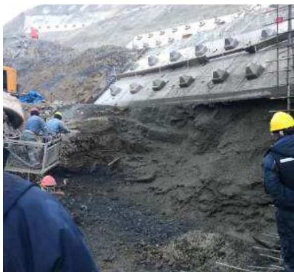
Lanzado de hormigón entre cotas 3765.08-3767.56
