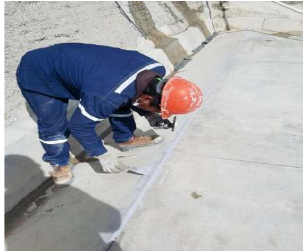
Colocado de Sikaflex para la banquina 3685.00
