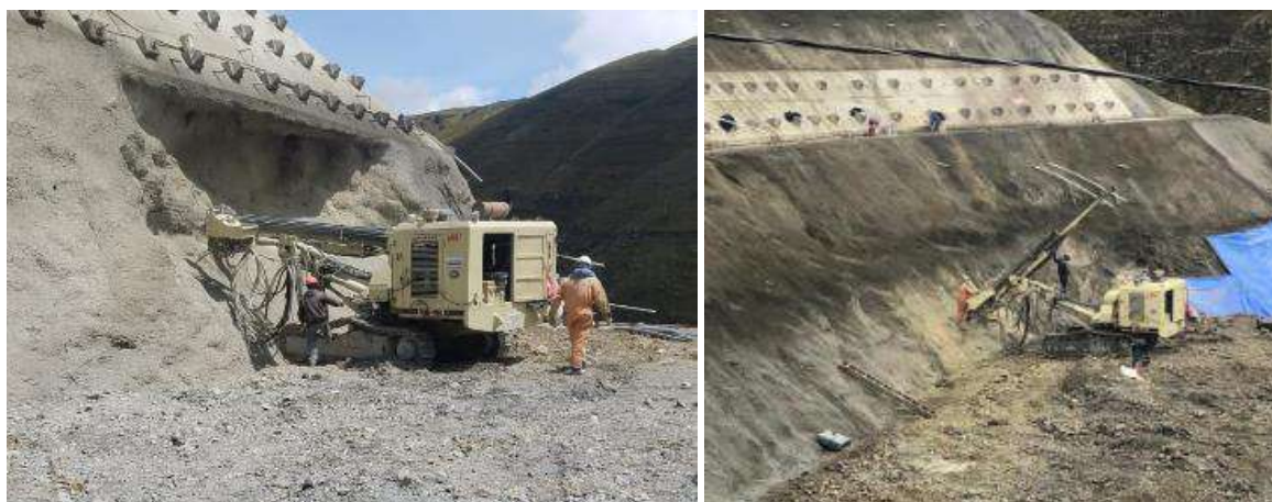
Colocado de pernos tipo A1 en talud cota 3772.00 – 3765.00
