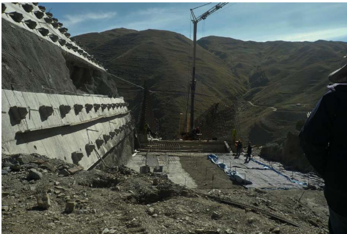
Foto N° 5 Hormigonado del canal del Vertedero ejes 5-6.
