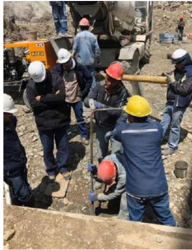
Perforación de barras de anclaje entre los ejes 4-5 y 9-10
