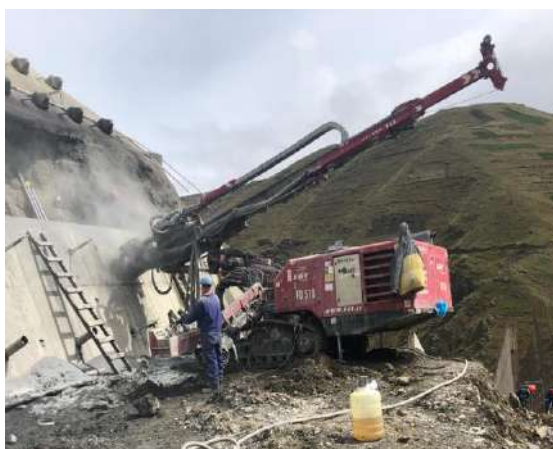
Perforación en la pantalla atirantada 3765.00
