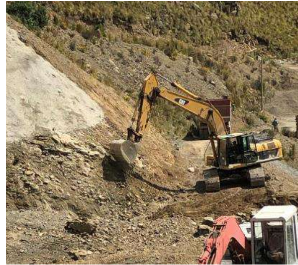
Excavación común y retiro de material para la banquina 3677.00 – 3670.00
