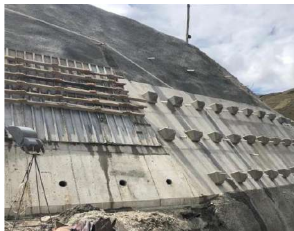
Hormigonado de la pantalla atirantada en cota 3772.00
