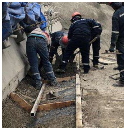
Hormigonado de la cuneta para la banquina en cota 3685.00
