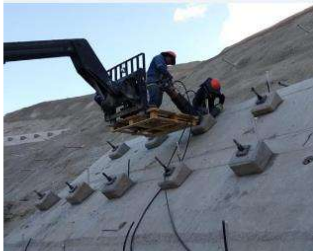
Pruebas de Carga de recibimiento y tesado de barras cota 3772.00
