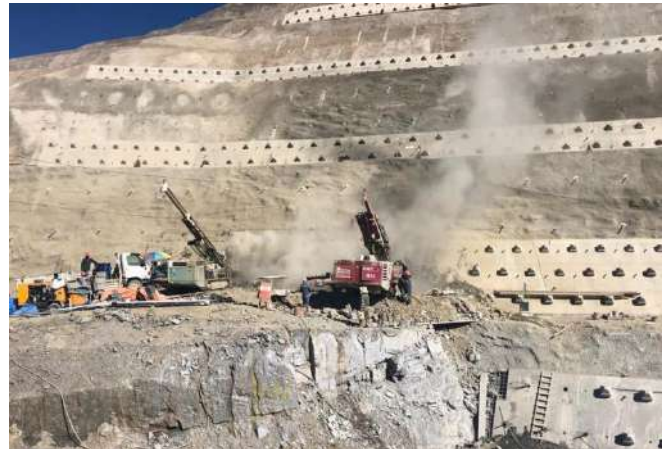
Perforación en la pantalla atirantada 3772.00-3767.50
