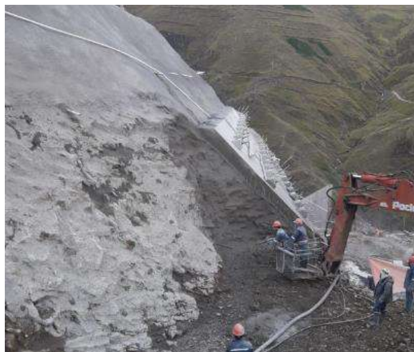
Proyectado de hormigón en el talud de la pantalla entre paño 8-9
