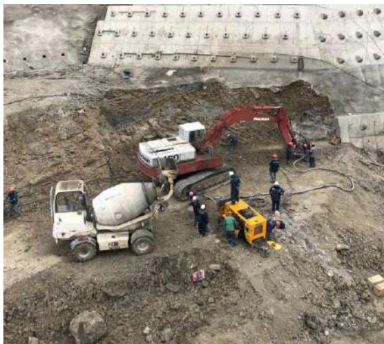
Lanzado de hormigón entre cotas 3769,00-3763,97
