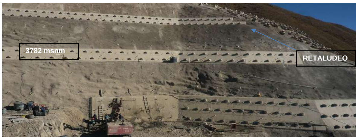
FIGURA 7-1 CONSTRUCCIÓN PANTALLAS ATIRANTADAS.
