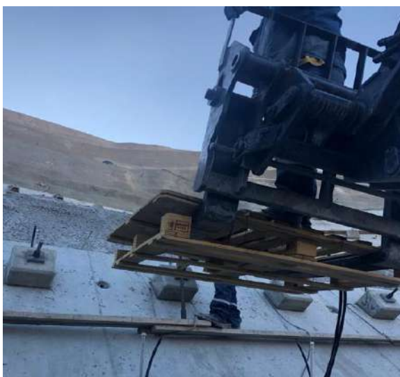
Pruebas de Carga de recibimiento y tesado de barras cota 3772.00
