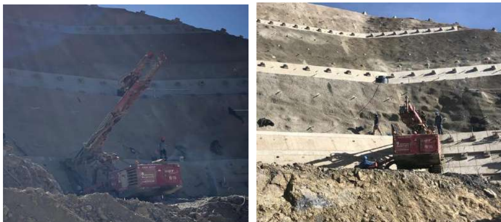
Instalación de barras Williams en la pantalla atirantada 3772.00 – 3767.50
