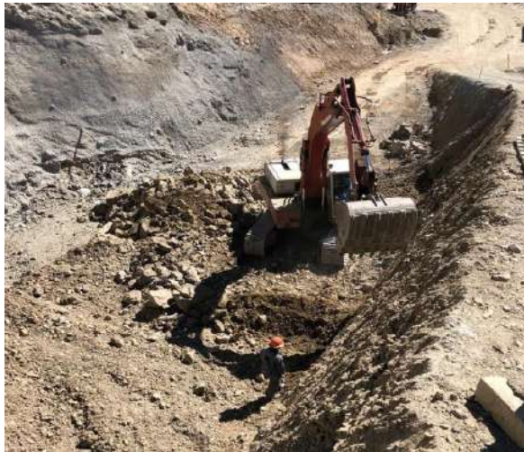
Excavación por voladura para conformación de taludes entre cotas 3665.26-3662.00
