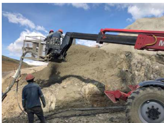
Lanzado de hormigón en el talud paño 7 y 8 eje 2-6
