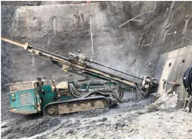
Perforaciones de las barras Williams para la pantalla atirantada cota 3675,00
