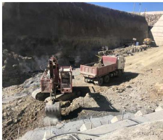
Excavación común y retiro de material para la pantalla atirantada y el canal del vertedero
