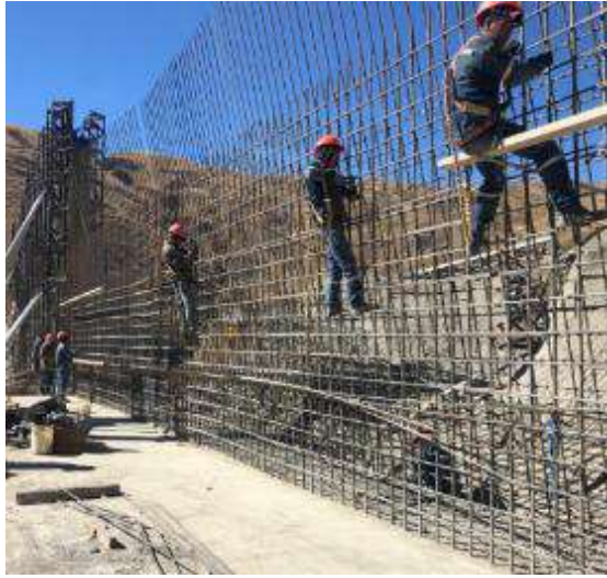
Colocado de acero para el canal del vertedero entre los ejes 4-5 y 9-10
