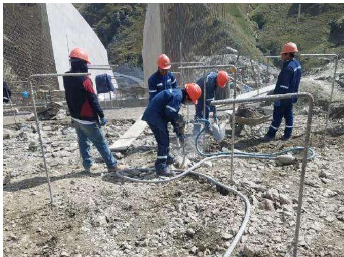
Colocado de hormigón tipo O para el vertedero en la cota 3657.00 – 3652.00
