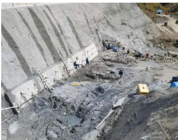
Colocado de drenes DHP`S para la pantalla atirantada 3675.00
