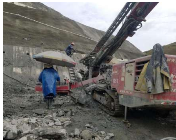
Instalacion de barras Williams en la pantalla atirantada 3772.00
