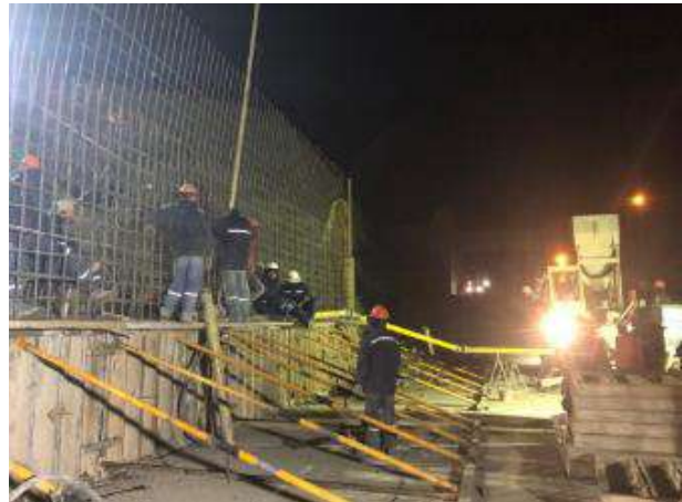
Hormigonado del muro superior e inferior para el canal del vertedero entre los ejes 5-6 y 9-10
