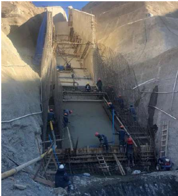
Hormigonado para la losa del canal del vertedero entre el eje 9-10
