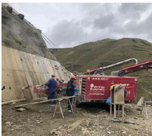
Perforación en la pantalla atirantada 3765.50
