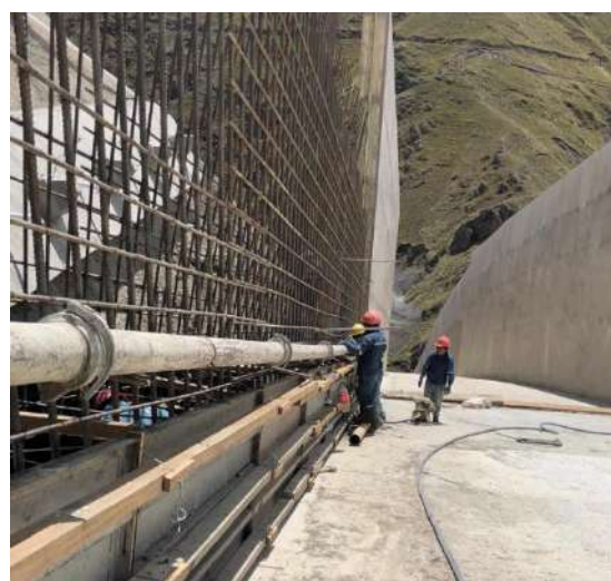
Hormigonado del muro para el canal del vertedero entre los ejes 5-6.
