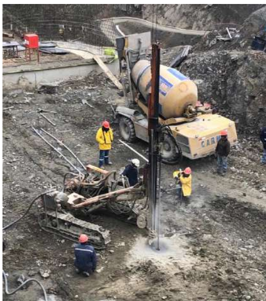
Perforación de barras de anclaje entre los ejes 4-5
