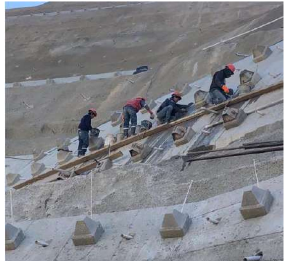
Recubrimiento de anclajes con pintura epóxica eje 2-6
