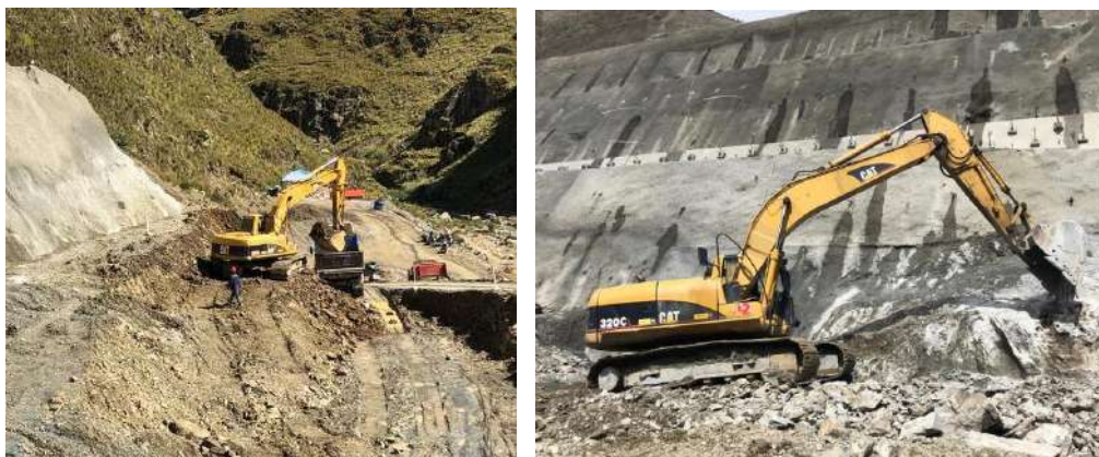
Excavación común y retiro de material para la banquina 3685.00 – 3670.00
