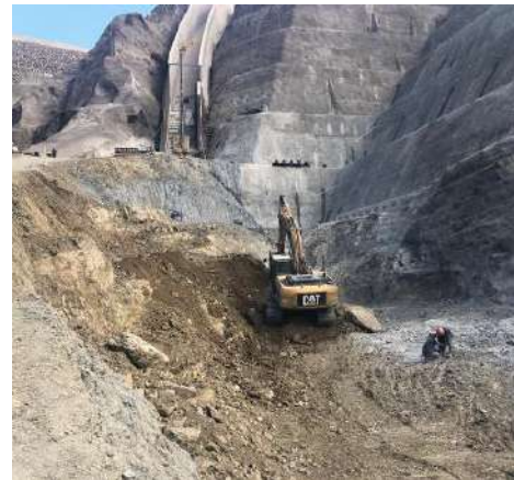
Excavación por voladura para conformación de taludes entre cotas 3670,00-3666,00
