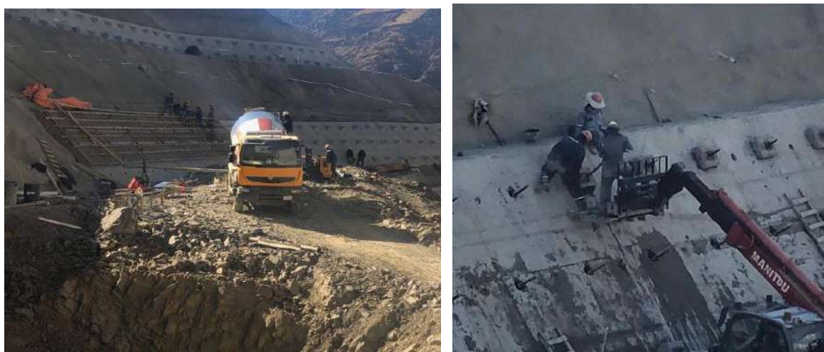
Colocado de hormigón tipo H para Pantalla en cota 3772.00
