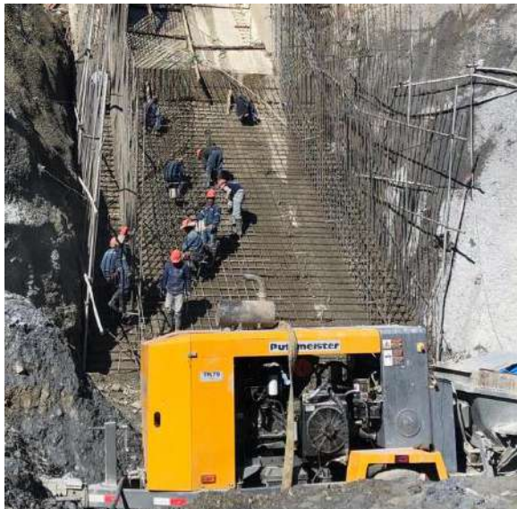
Hormigonado tipo O ejes 9-10
