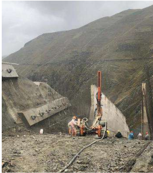
Perforación de barras de anclaje entre los ejes 5-6
