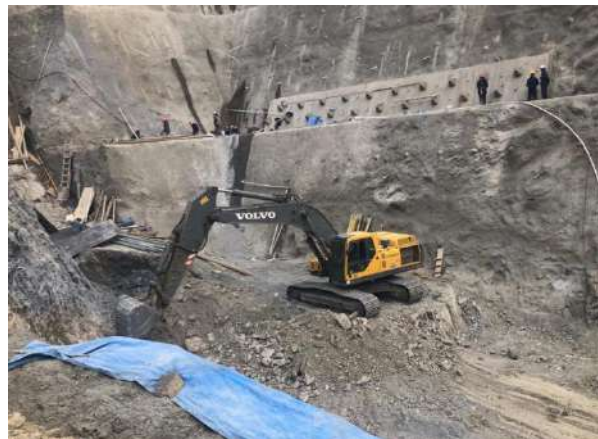
Excavación común y retiro de material para el canal del vertedero entre los ejes 10-11
