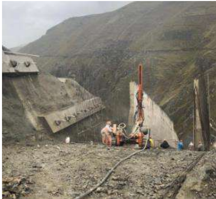
Perforación de las barras de anclajes ejes 5-6
