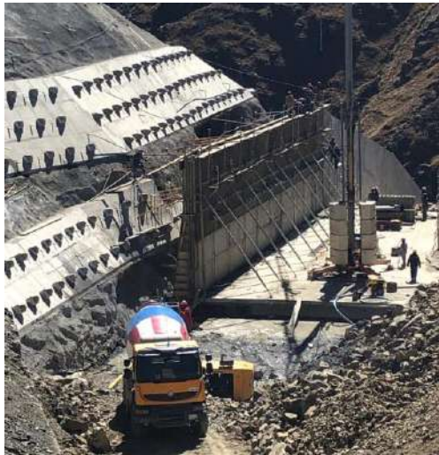
Hormigonado del muro superior e inferior para el canal del vertedero entre los ejes 5-6 y 9-10
