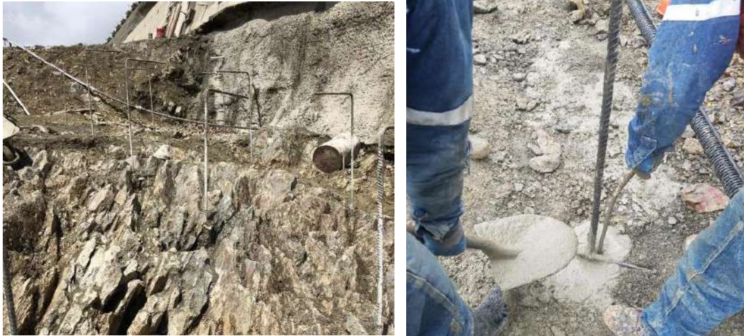
Perforación de barras de anclaje entre los ejes 5-6
