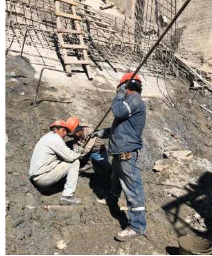
Perforación de barras de anclaje entre los ejes 4-5 y 9-10
