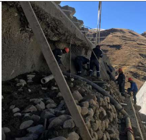
Relleno con mampostería de piedra cota 3772.00
