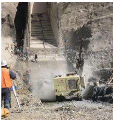
Perforación de barras de anclaje entre los ejes 9-10
