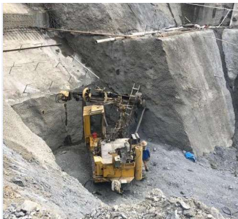
Perforación e instalación de pernos tipo A1 para el canal del vertedero entre los ejes 9-10
