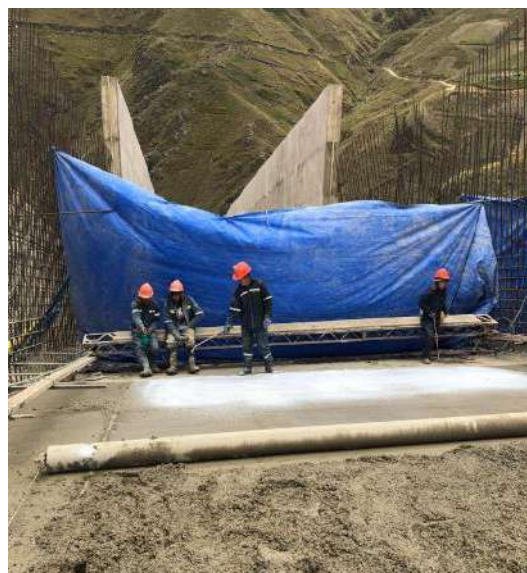
Se realizó el hormigonado tipo H para la losa entre ejes 5-6 y 9-10
