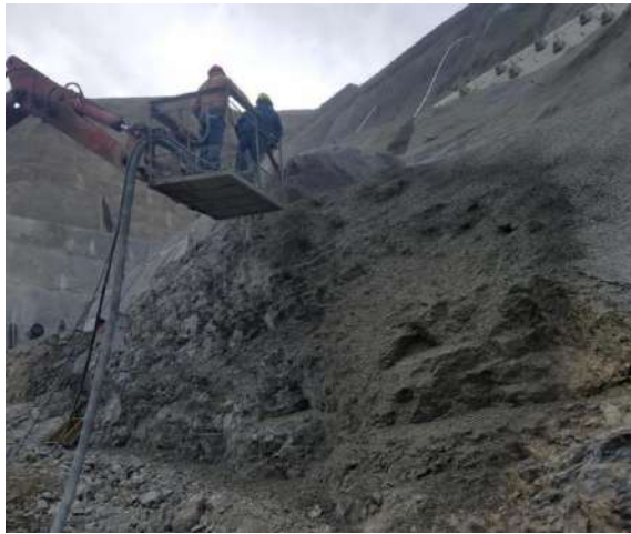
Proyectado de hormigón en el talud de la pantalla 3685,00 -3668,00
