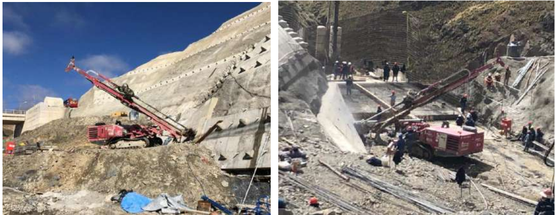
Perforación de barras Williams cota 3772.00 – 3767.50 paño 7
