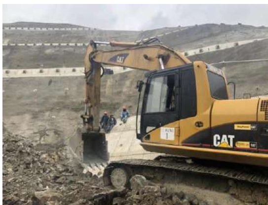
Excavación común y retiro de material para la banquina 3775.50 – 3772.00
