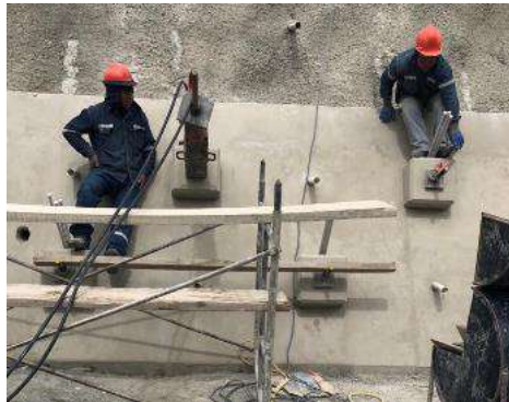
Pruebas de Carga de recibimiento y tesado de barras cota 3685.00
