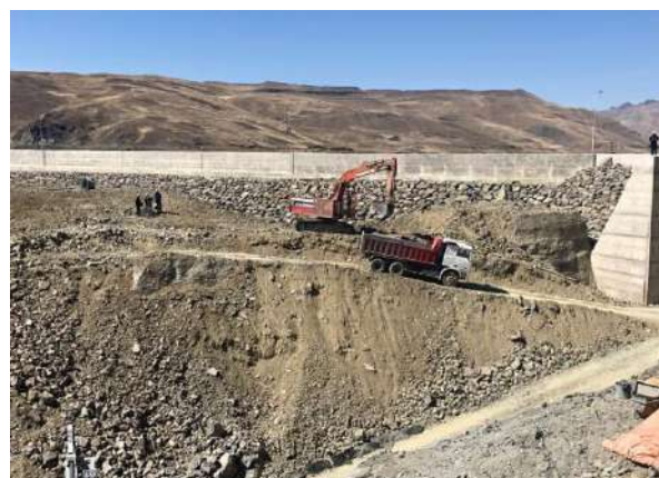
Excavación común y retiro de material para la pantalla atirantada y el canal del vertedero eje 3-4
