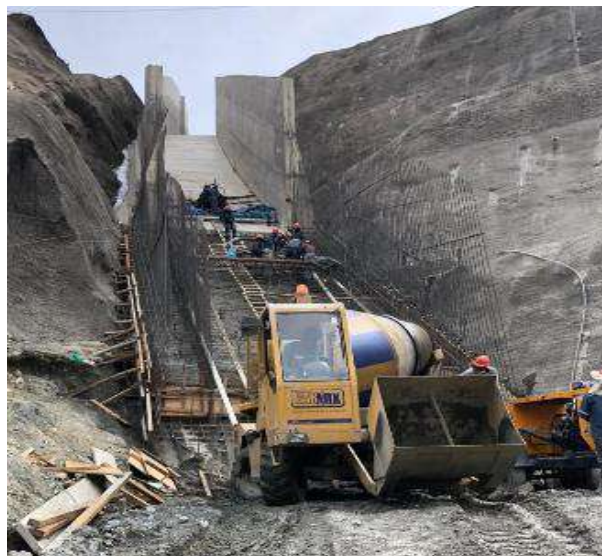
Colocado de hormigón tipo O para el vertedero en la cota 3685.00
