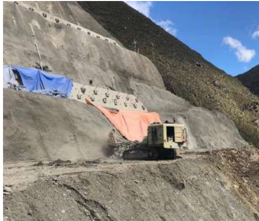
Colocado de pernos tipo A1 en talud cota 3685.00 – 3680.00
