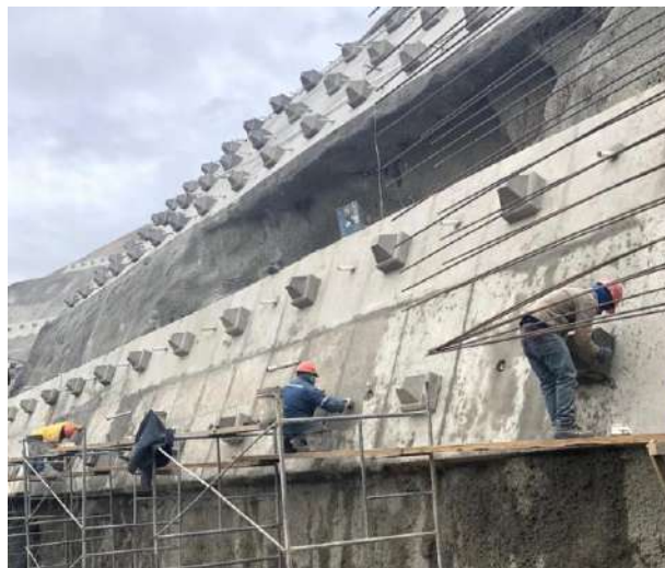
Colocado de pintura epóxica dados para los anclajes en la pantalla de cota 3768.50
