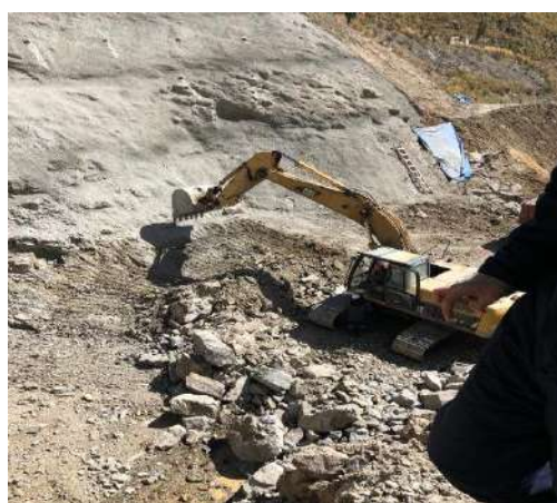
Excavación común y retiro de material para la banquina 3668,00-3685,00
