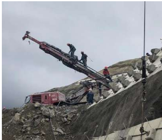
Instalacion de barras Williams en la pantalla atirantada 3772.00
