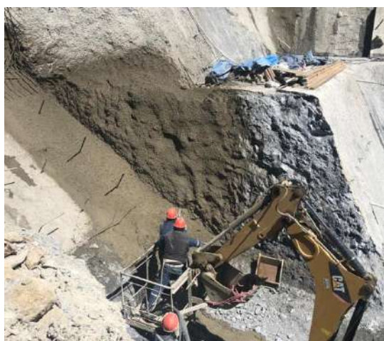
Proyectado de hormigón en el talud de la pantalla 3671,50-3667,53
