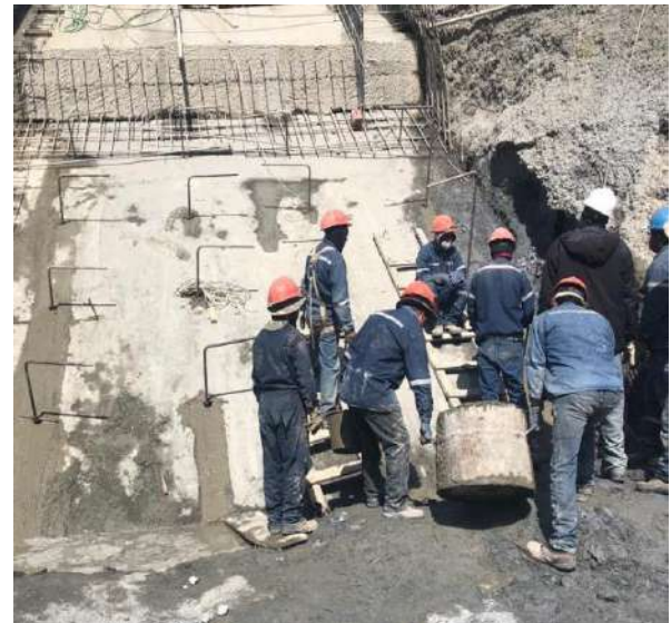
Perforación de barras de anclaje entre los ejes 9-10
