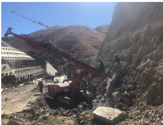
Perforación e instalación de pernos A1 en talud derecho entre cotas 3767.00 eje 3-4
