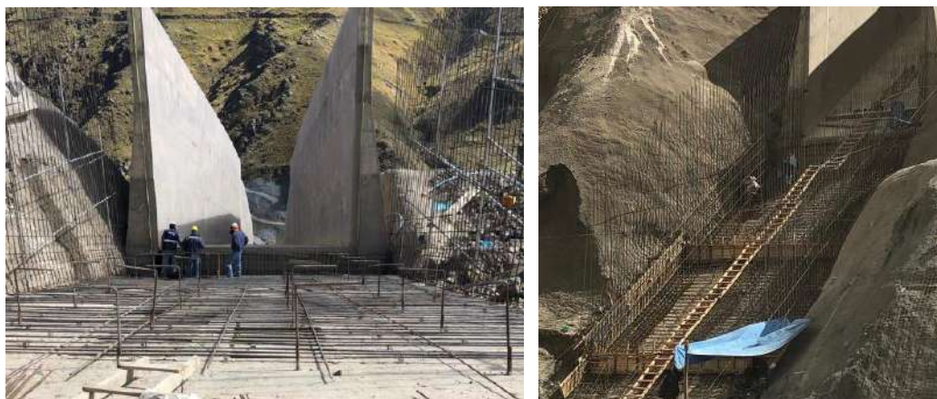
Colocado de acero de refuerzo para el canal de vertedero
