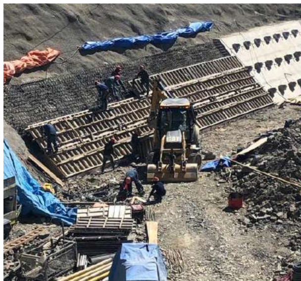
Hormigonado para la pantalla atirantada 3772.00
