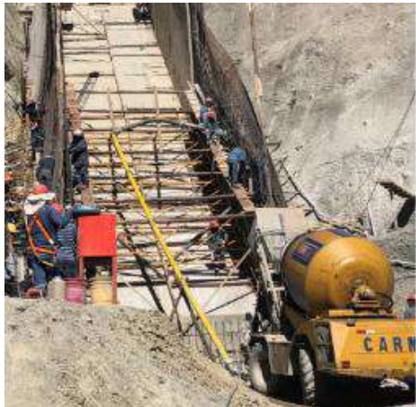
Hormigonado del muro superior e inferior para el canal del vertedero entre los ejes 5-6 y 9-10
