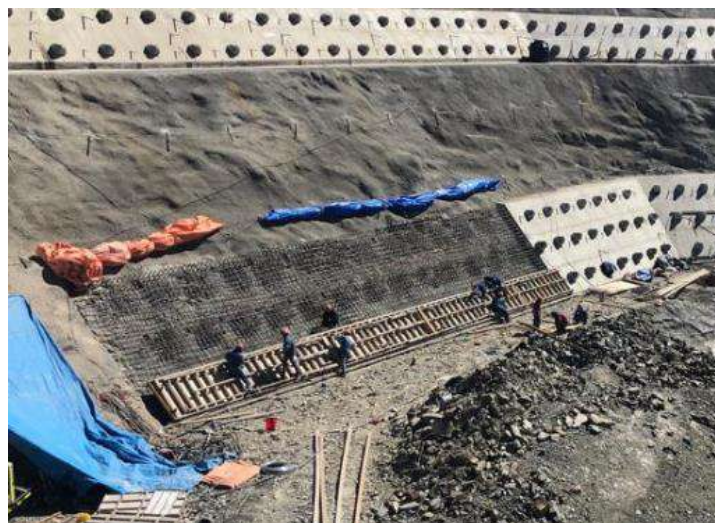
Colocado de acero de refuerzo para la pantalla atirantada 3772.00
