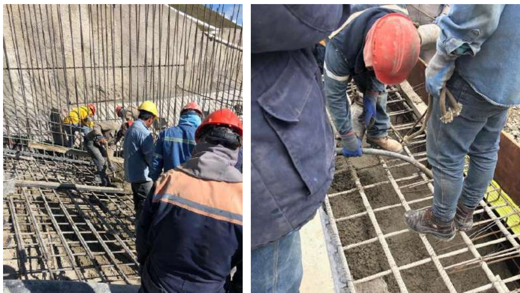
Se realizó hormigonado tipo O para la losa entre ejes 5-6
