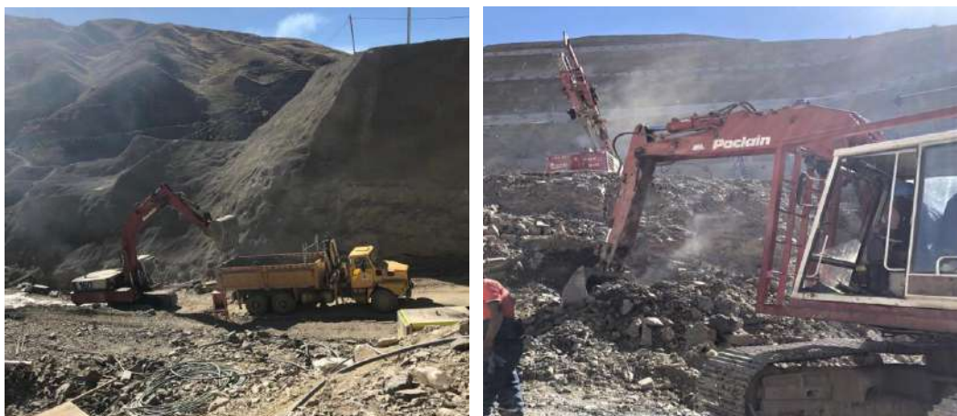
Excavación común y retiro de material para la banquina 3771.00 – 3766.00
