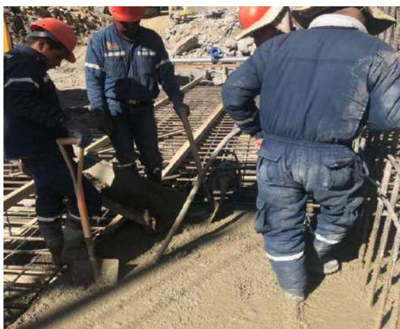
Hormigonado para la losa del canal del vertedero entre el eje 3-4
