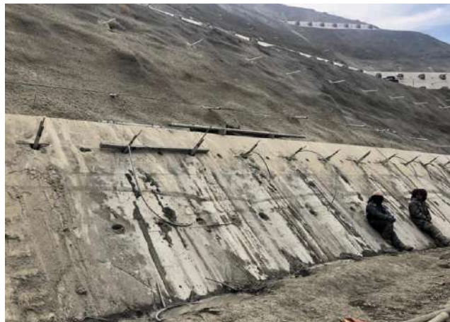
Instalación de barras Williams en la pantalla atirantada 3772.00
