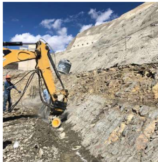
Excavación común y retiro de material para la banquina 3768.50 – 3765.50
