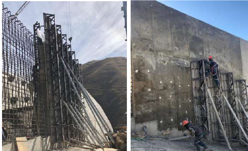
Hormigonado del muro superior e inferior para el canal del vertedero entre las cotas 3756,00 - 3694,90
