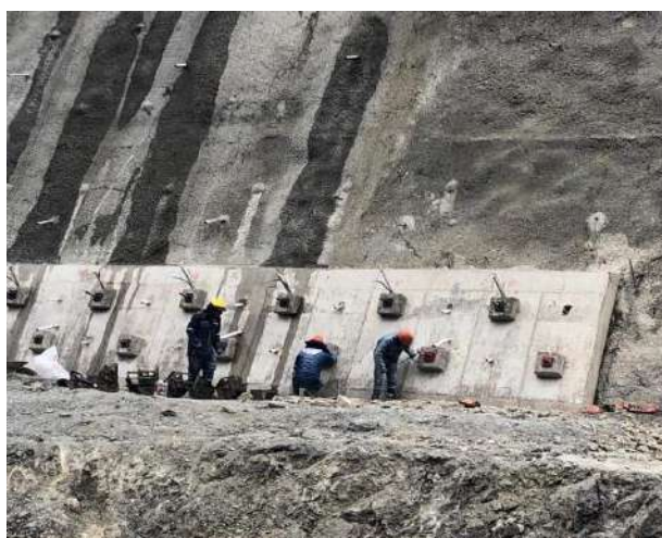
Colocado de pintura epóxica y recubrimiento de anclajes para la pantalla atirantada 3675.00
