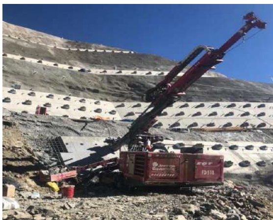
Perforación en la pantalla atirantada 3772.00-3767.50
