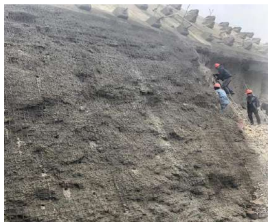
Colocado de malla electrosoldada
