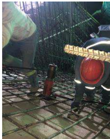
Pruebas de carga para las barras de anclaje para el canal del vertedero entre los ejes 9-10
