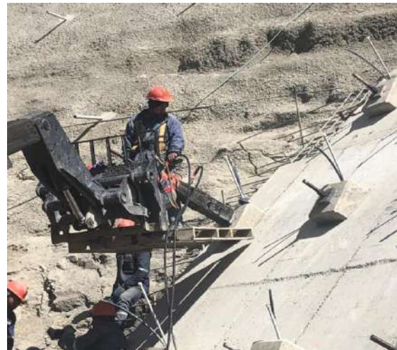
Pruebas de Carga de recibimiento y tesado de barras cota 3772.00
