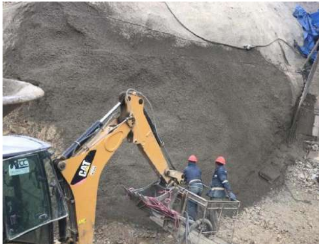
Proyectado de hormigón en el talud de la pantalla 3683.80-3671.96
