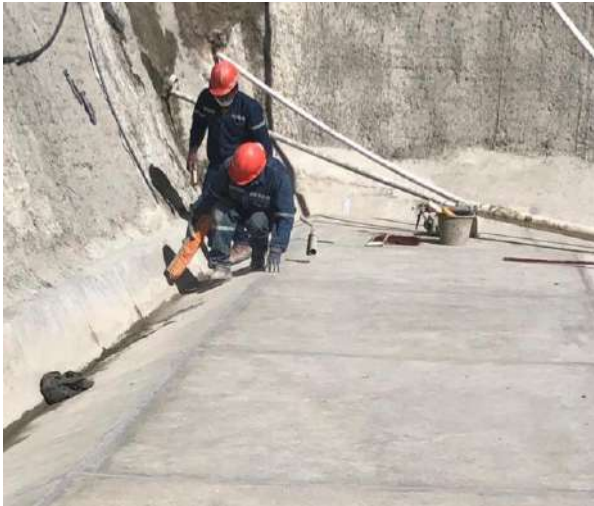
Colocado de Sikaflex para la banquina 3685.00
