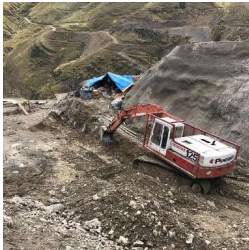
Excavación común y retiro de material para la banquina 3768.50 – 3765.50
