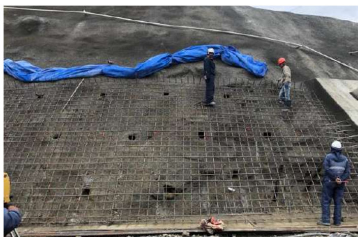
Armado de la pantalla atirantada cota 3772 paño 8
