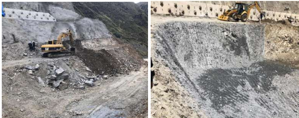
Excavación común y retiro de material para la banquina 3685.00 – 3677.00
