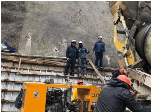
Proyectado de hormigón en el talud de la pantalla 3675.00
