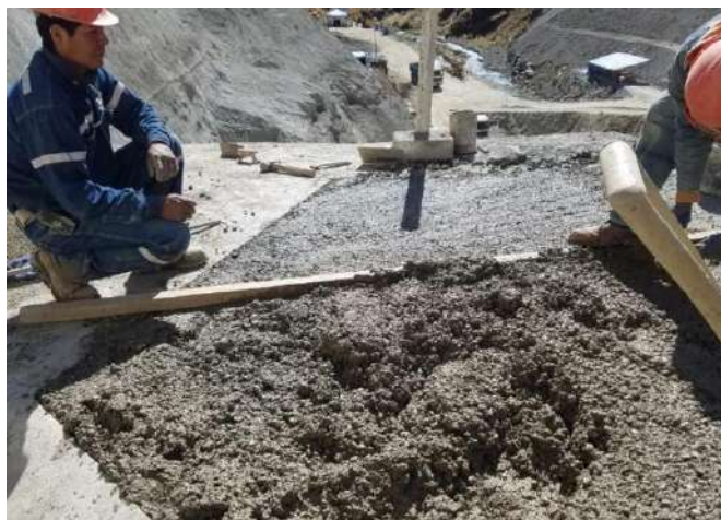
Hormigonado de la banquina entre cotas 3685.00
