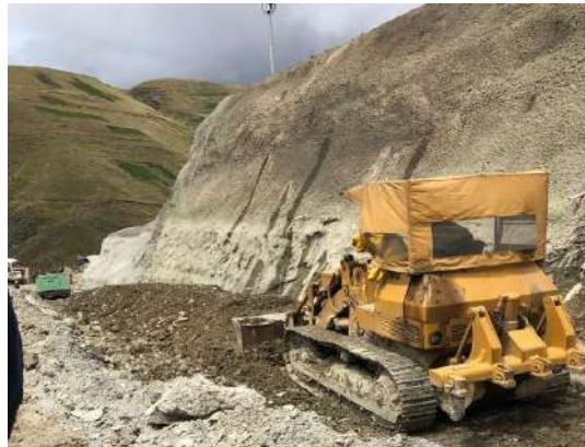
Excavación común y retiro de material para la banquina 3668,00 - 3669,00
