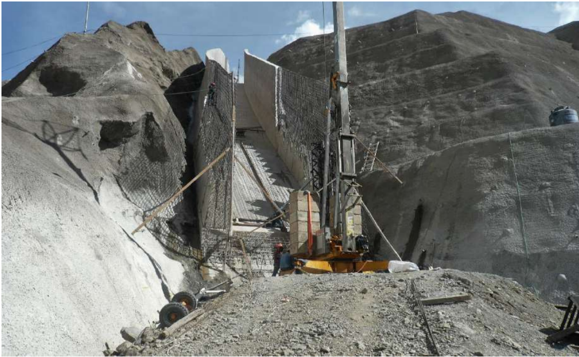
Foto N° 9 Hormigonado canal vertedero eje 9.
