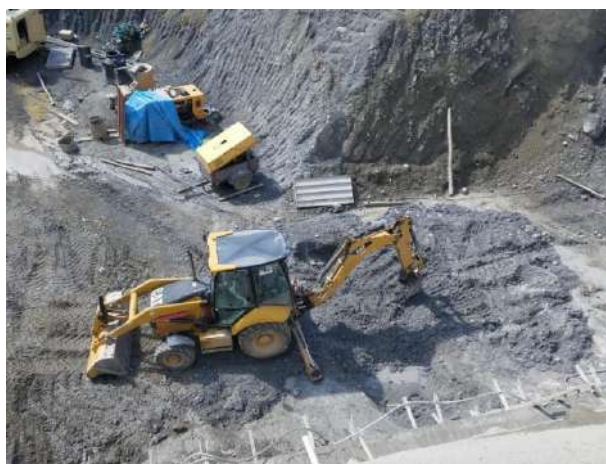
Excavación común y retiro de material 3677.00 – 3670.00
