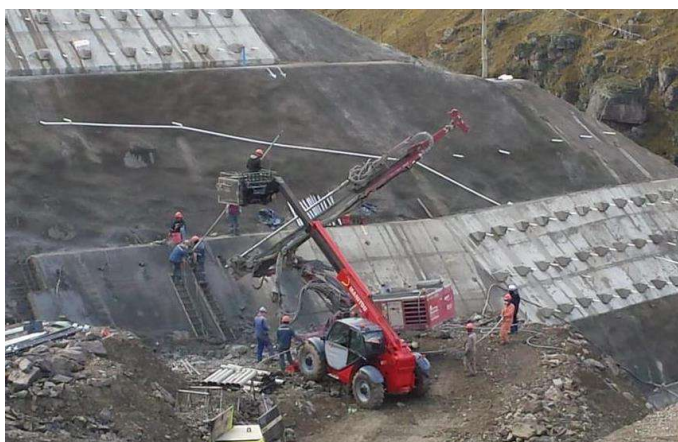
Instalación de barras Williams en la pantalla atirantada 3772.00
