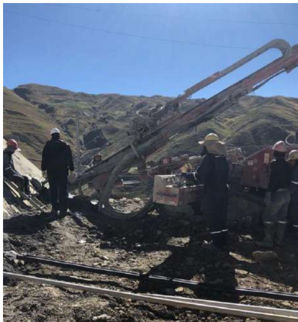
Colocado de drenes DHP'S en el paño 8 cota 3772.00
