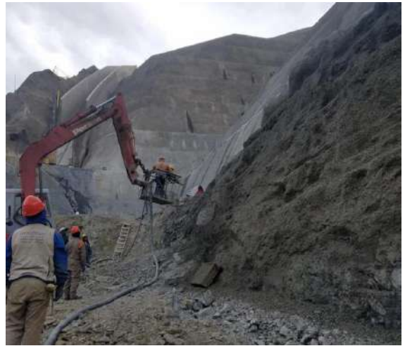
Proyectado de hormigón en el talud de la pantalla 3685,00 -3668,00
