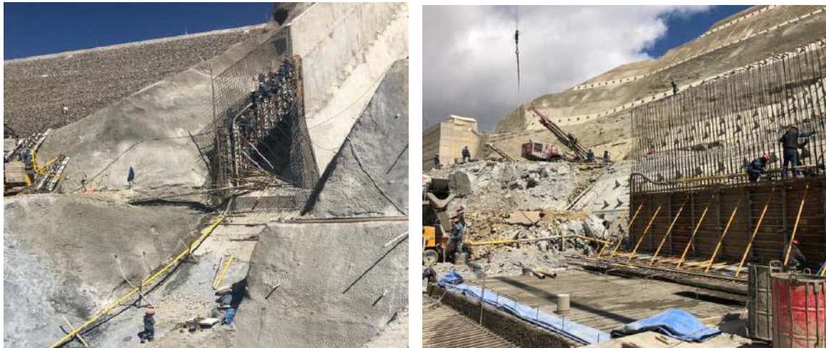
Hormigonado del muro superior e inferior para el canal del vertedero entre los ejes 3-4 y 9-10
