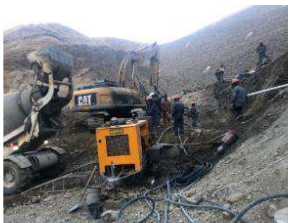
Proyectado de hormigón en el talud de la pantalla 3684.92-3668.92
