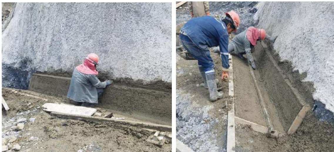
Perforación y colocado de DHPs en el talud cotas 3685.00
