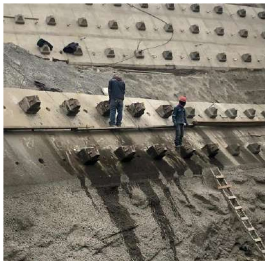
Recubrimiento de anclajes con pintura epóxica eje 2-6
