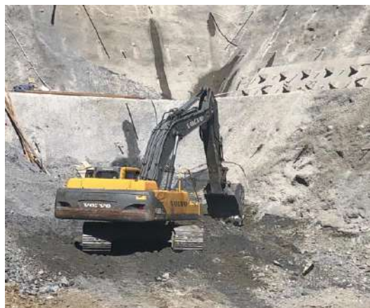
Excavación común y retiro de material para el canal del vertedero entre los ejes 10-11
