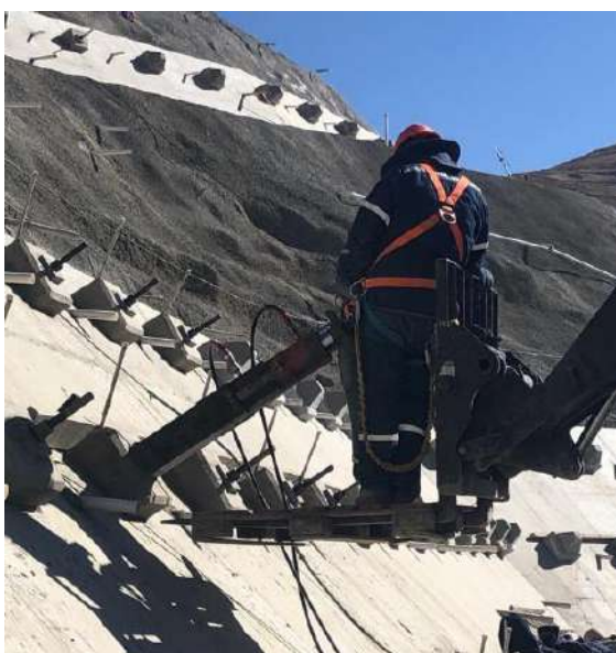
Pruebas de Carga de recibimiento y tesado de barras cota 3772.00
