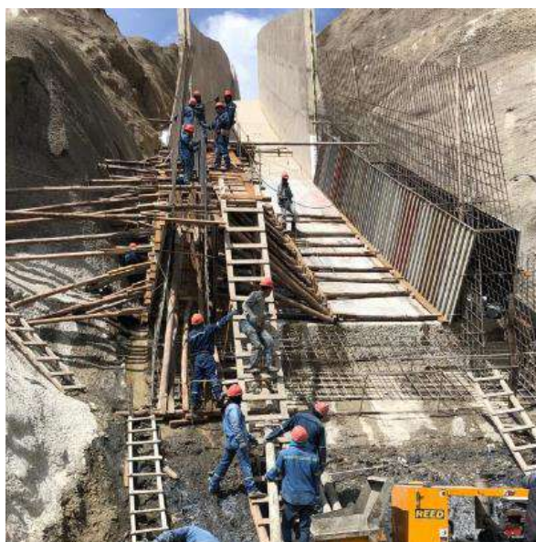
Colocado de hormigón tipo O para el vertedero en la cota 3697.05 – 3698.
