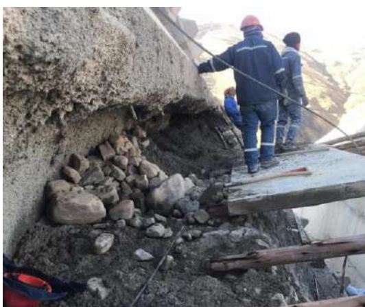
Relleno con mampostería de piedra cota 3772.00
