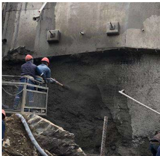
Proyectado de hormigón en el talud de la pantalla entre paño 8-9
