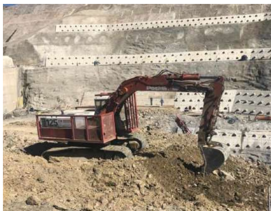
Excavación común y retiro de material para la pantalla atirantada y el canal del vertedero eje 3-4
