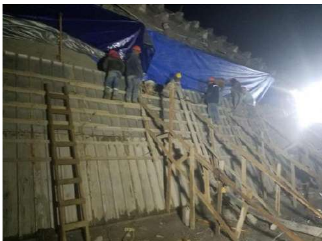
Colocado de acero de refuerzo en cota 3772.00
