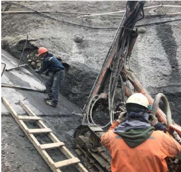
Perforación de barras de anclaje entre los ejes 9-10
