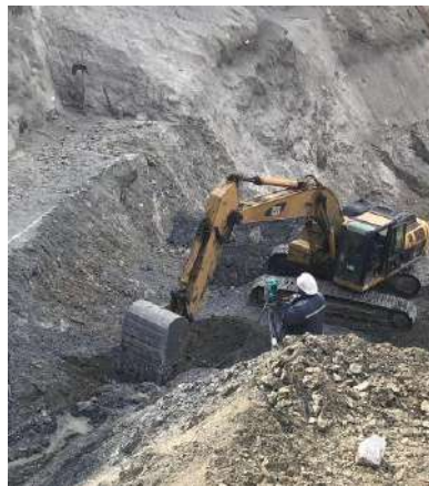
Excavación por voladura para conformación de taludes entre cotas 3670,00-3666,00
