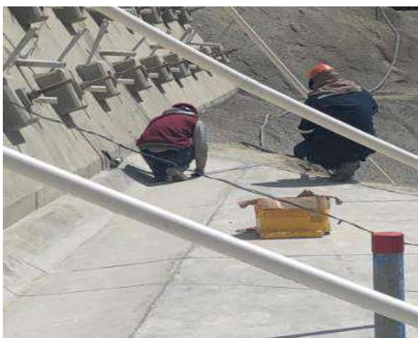
Colocado de Sikaflex para la banquina 3685.00
