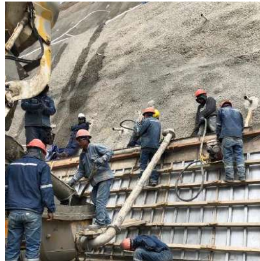
Proyectado de hormigón en el talud de la pantalla 3675.00
