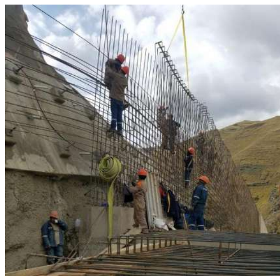
Colocado de acero para el canal del vertedero cota 3687.00 eje 5-6
