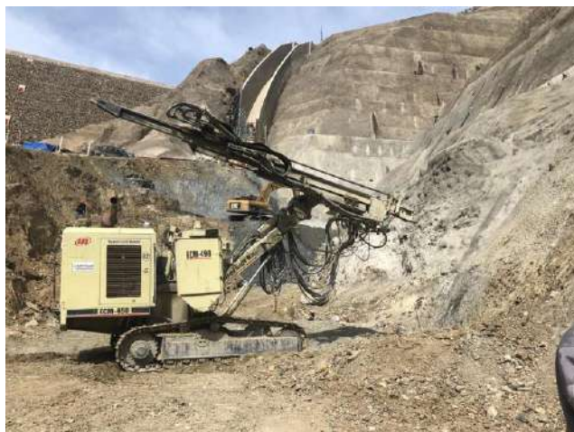
Colocado de drenes DHP`S para la pantalla atirantada 3663,00-3665,26
