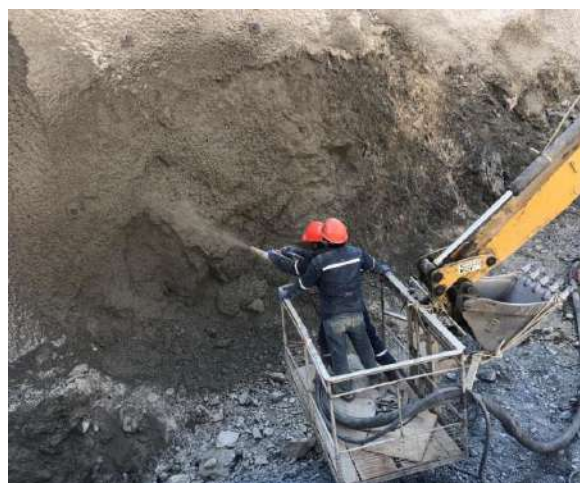
Proyectado de hormigón en el talud de la pantalla 3671,50-3667,53
