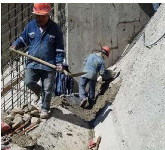
Hormigonado de la cuneta revestida con concreto simple entre cotas 3685.00
