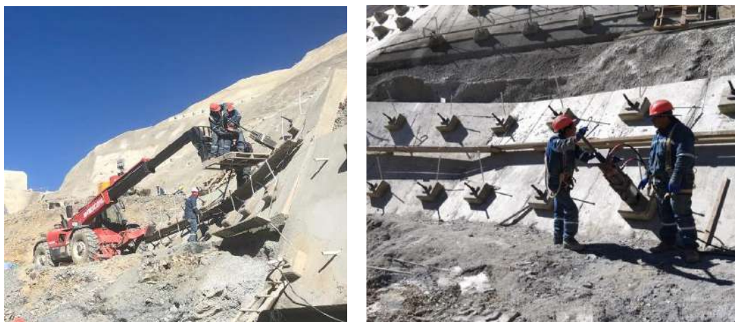
Pruebas de Carga de recibimiento y tesado de barras cota 3767,50
