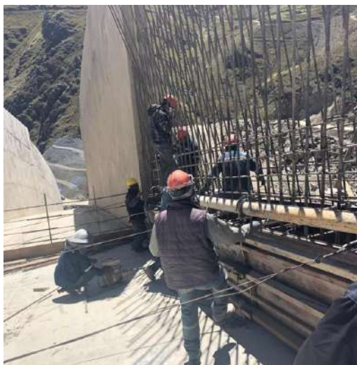
Hormigonado del muro para el canal del vertedero entre los ejes 5-6.
