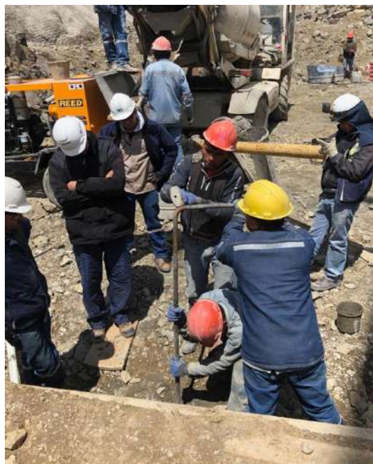
Perforación de barras de anclaje entre los ejes 4-5
