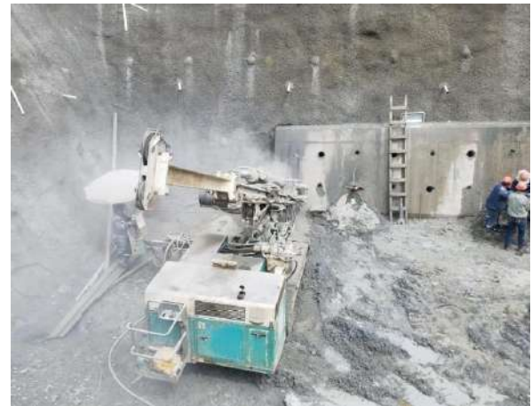
Perforaciones de las barras Williams para la pantalla atirantada cota 3675,00
