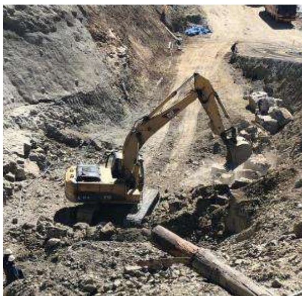
Excavación por voladura para conformación de taludes entre cotas 3668.00 - 3665.26
