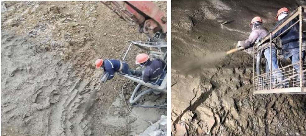
Proyectado de hormigón en el talud de la pantalla 3685.00 – 3680.00
