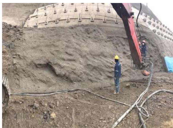
Lanzado de hormigón en el talud paño 7 y 8 eje 2-6
