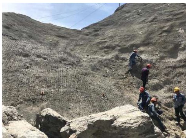
Colocado de malla electrosoldada
