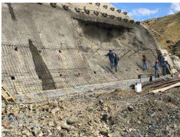
Colocado de acero de refuerzo en cota 3765.00
