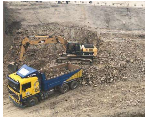
Excavación común y retiro de material para la banquina 3772.00 – 3767.00
