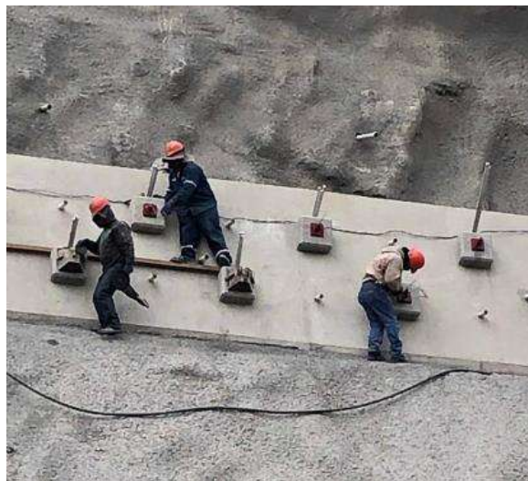
Colocado de pintura epóxica y recubrimiento de conos truncados para la pantalla 3685.00
