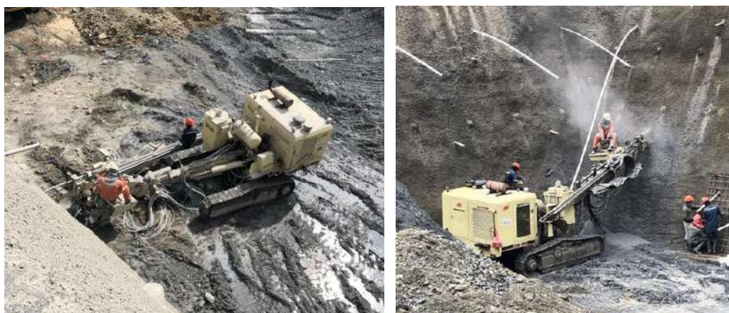
Perforación y colocado de DHP's en el talud cotas 3685.00 – 3675.00
