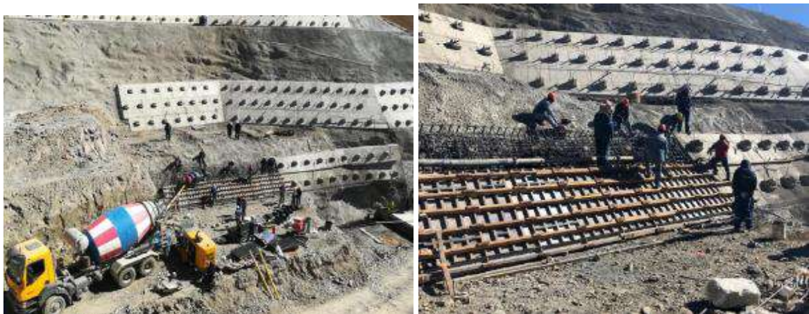
Hormigonado para la pantalla atirantada 3772.00 – 3768.00
