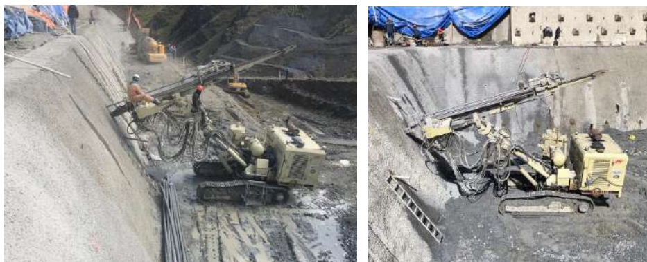
Perforación y colocado de pernos A1 entre eje 10-11
