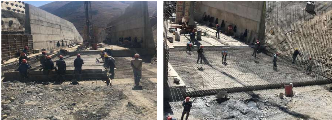
Colocado de acero para el canal del vertedero entre los ejes 3-4
