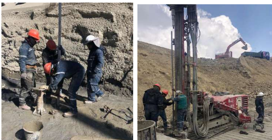
Perforación de barras de anclaje entre los ejes 9-10
