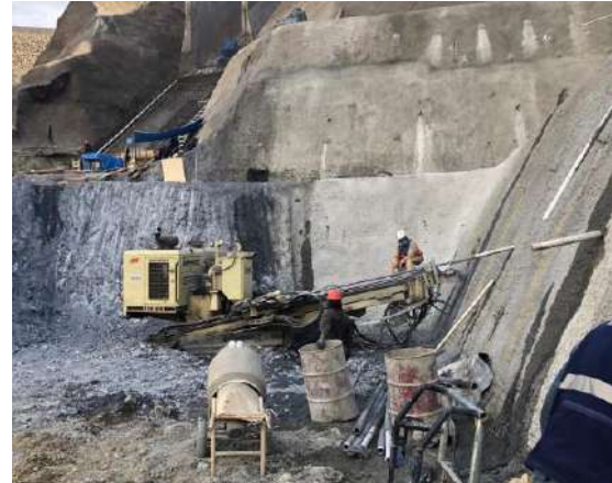
Colocado de pernos tipo A1 en talud cota 3685.00 – 3680.00
