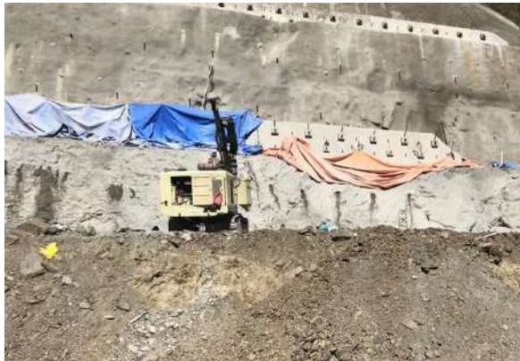
Perforación de DHP en el talud y la pantalla de cota 3685.00 – 3680.00
