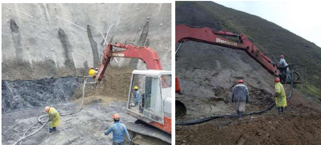
Proyectado de hormigón en el talud de la pantalla 3685.00 – 3682.00
