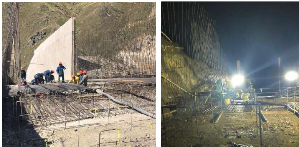
Se realizó el hormigonado tipo H entre ejes 5-6 y 9-10
