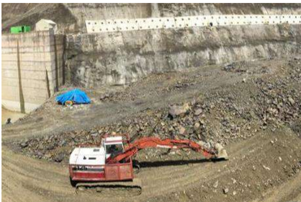
Excavación común y retiro de material para la banquina 3668,00 - 3669,00
