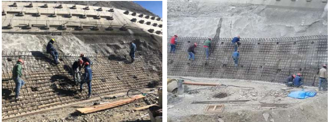
Colocado de acero de refuerzo para la pantalla atirantada 3767.50 – 3772.00
