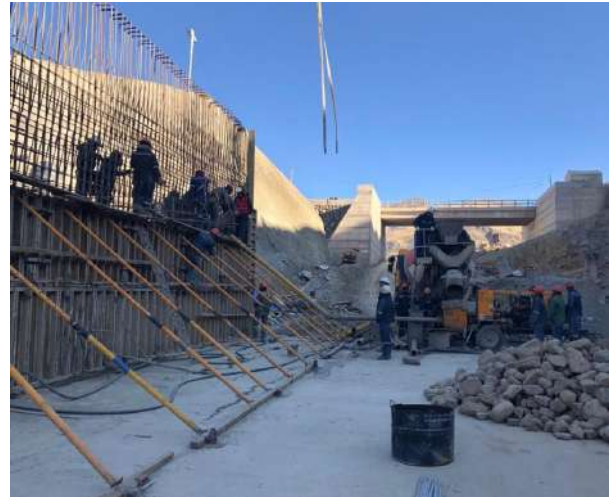
Hormigonado del muro superior e inferior para el canal del vertedero entre los ejes 5-6 y 9-10
