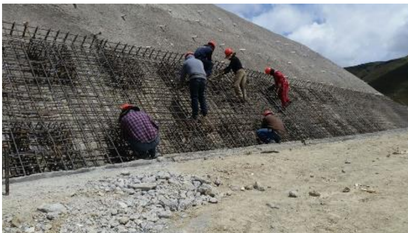
Colocado de acero de refuerzo pantalla cota 3802.00
