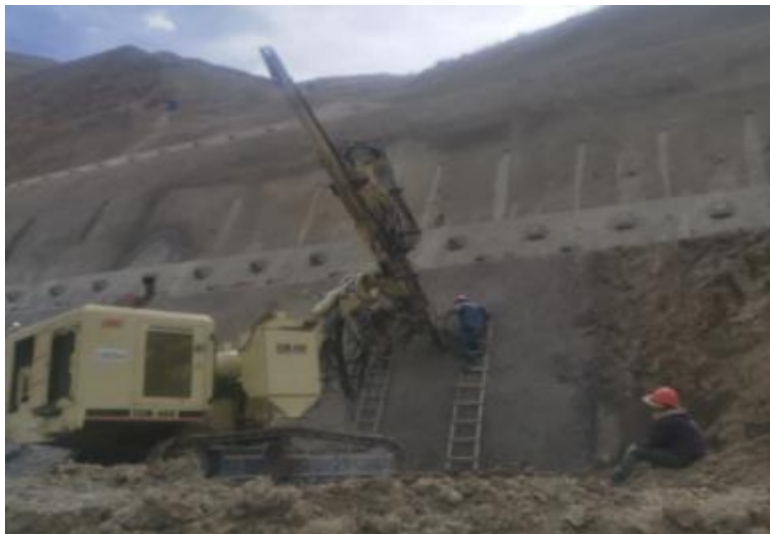
Colocado de pernos tipo A1 en talud cota 3705.00 – 3690.00
