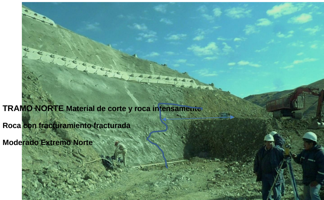
FOTO N° 2 Talud sobre banquina 3782 extremo Norte tramo Norte con la Falla Vertedero en su base.
