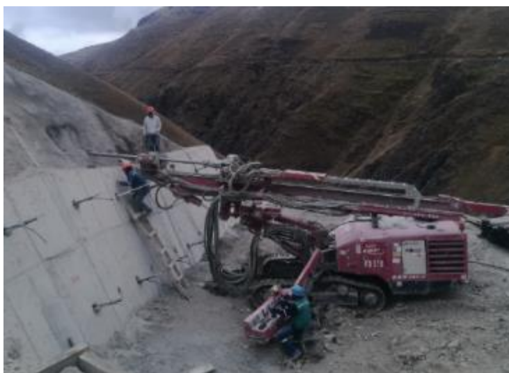
Perforación de DHP en la pantalla de cota 3765.00
