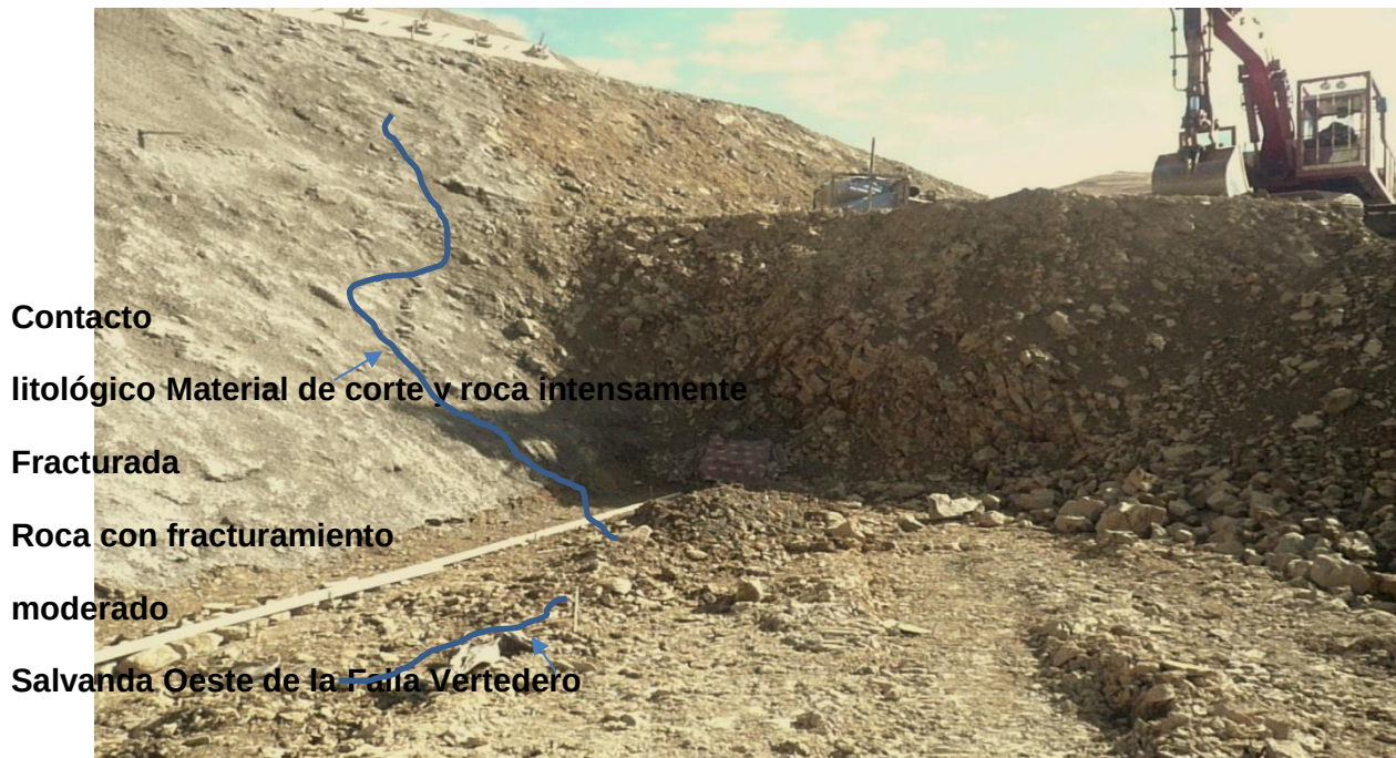
FOTO N° 2 Talud sobre banquina 3782 extremo Norte tramo Norte con la Falla Vertedero en su base.
