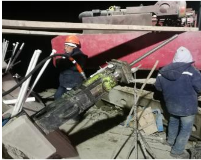
Pruebas de Carga tipo A, B y calificación y tesado de barras pantalla 3705.00
