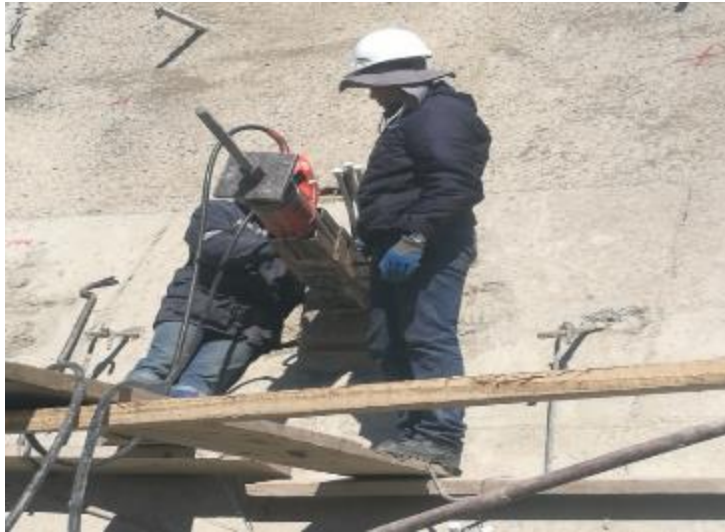
Pruebas de Carga de recibimiento y tesado de barras cota 3802.00
