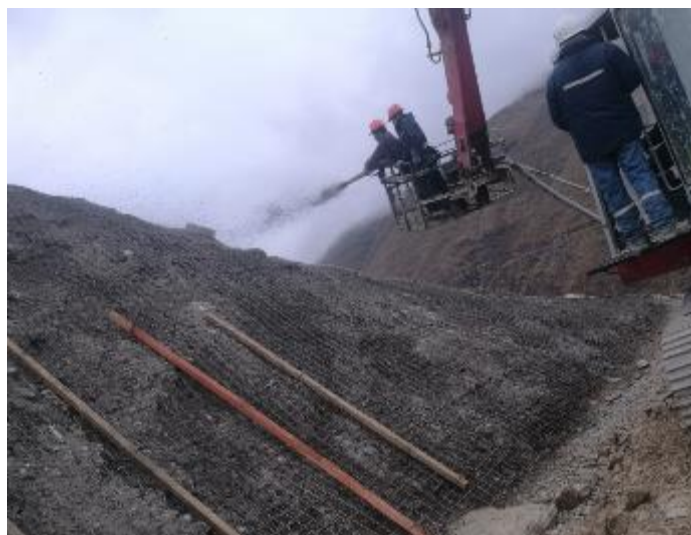
Colocado de hormigón lanzado talud para la banquina 3772.00
