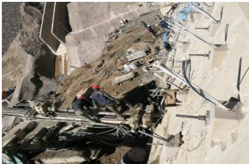
Perforación de DHP's pantalla 3705.00
