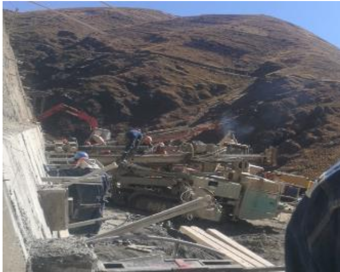
Hormigonado dados pantalla atirantada cota 3695.00
