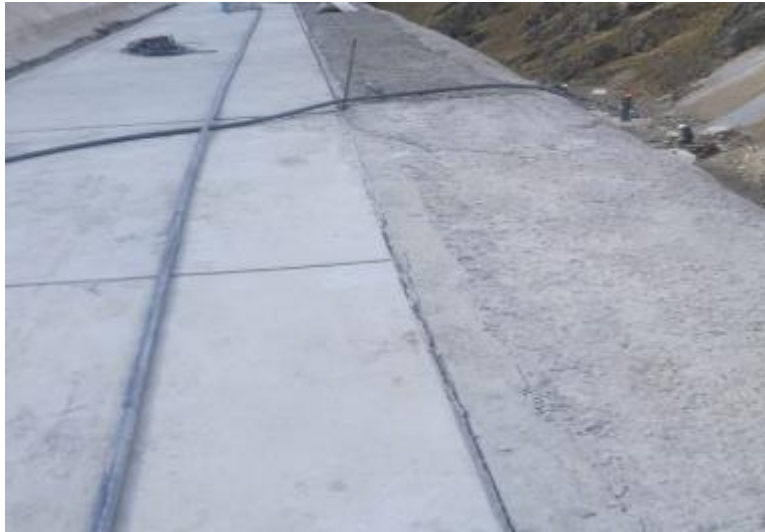
Colocado de Sikaflex en cota 3705.00
