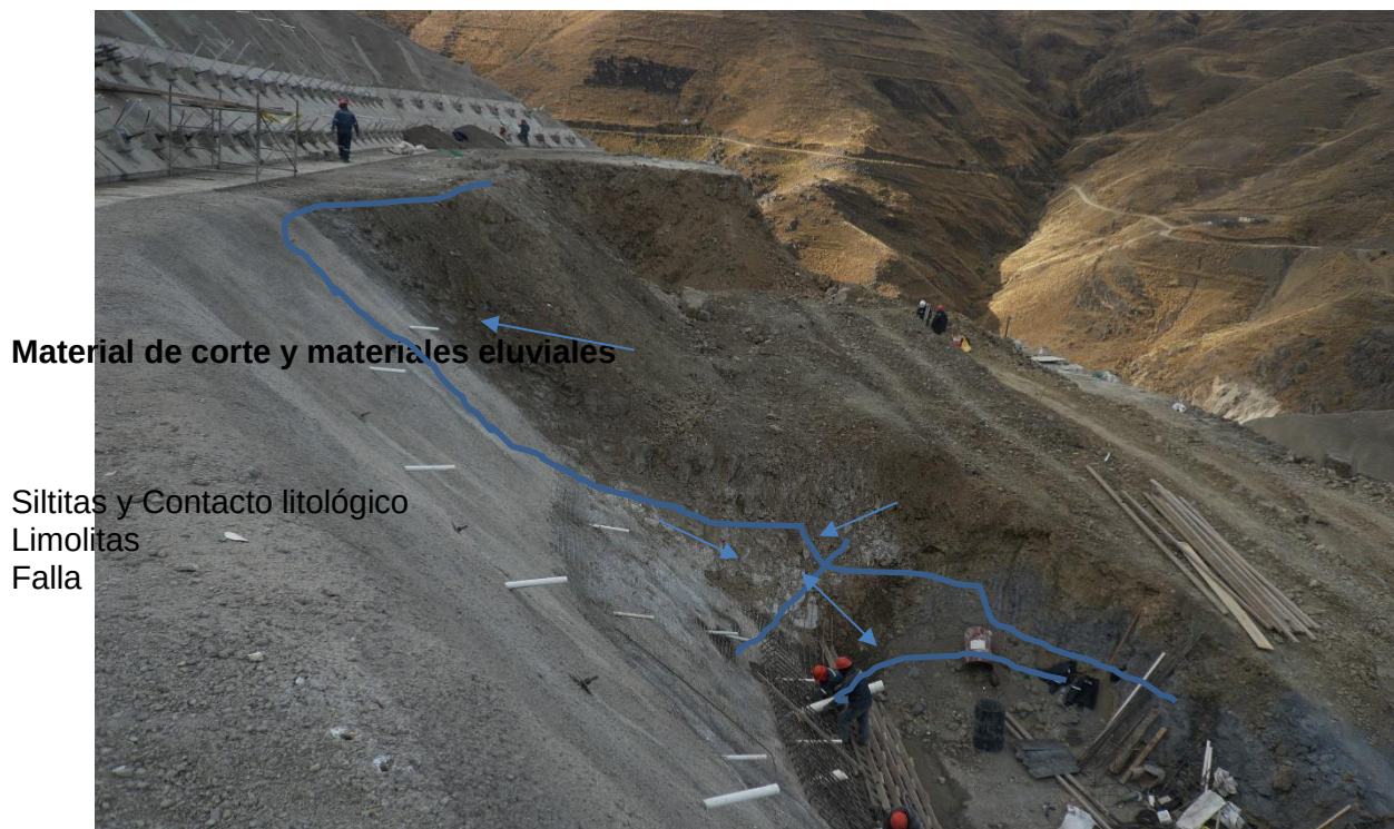
Foto N° 1 Banquina 3 782 exponiendo la falla con milonita gris azulado
