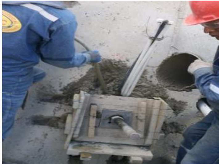
Hormigonado tipo H de dados de anclaje de la pantalla atirantada cota 3705.00
