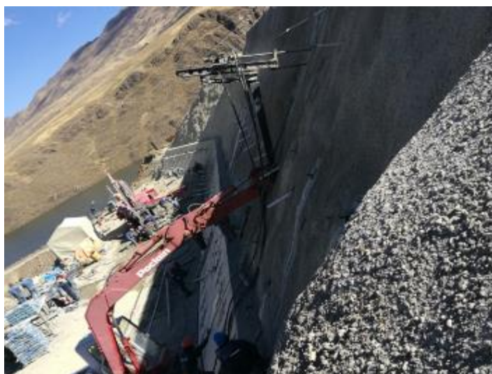
Perforación pernos A1 talud 3802.00 a 3792.00.
