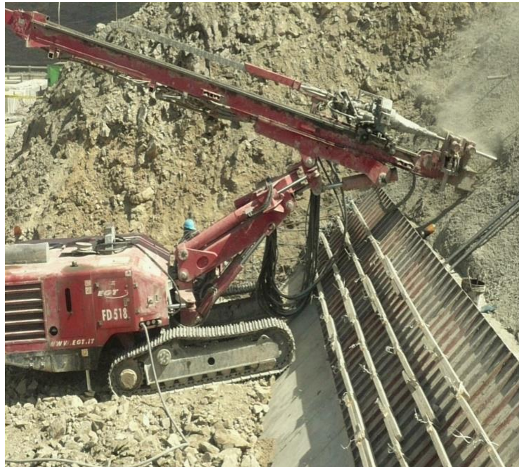
Perforación En Roca Paño 3 Cota 3 782
