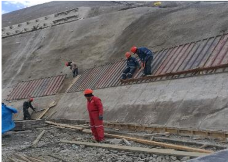
Encofrado segunda etapa pantalla 3792.00
