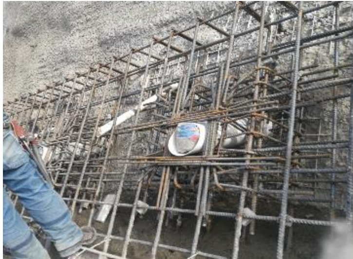
Colocado de acero de refuerzo en dados pantalla cota 3705.00
