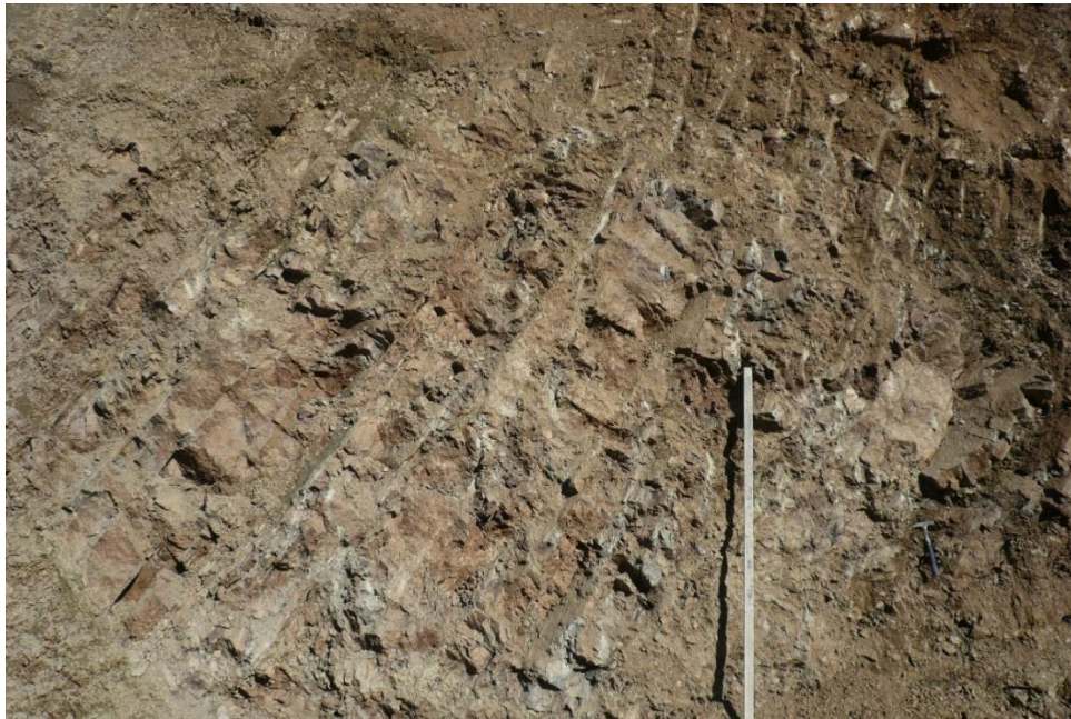
FOTO N° 4 Afloramiento de limolitas y siltitas con fracturamiento moderado talud comprendido entre cotas 3695 y 3705 (sector Norte).
