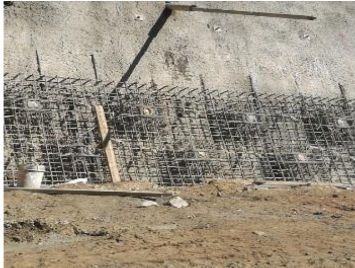
Colocado de acero de refuerzo pantalla 3695.00
