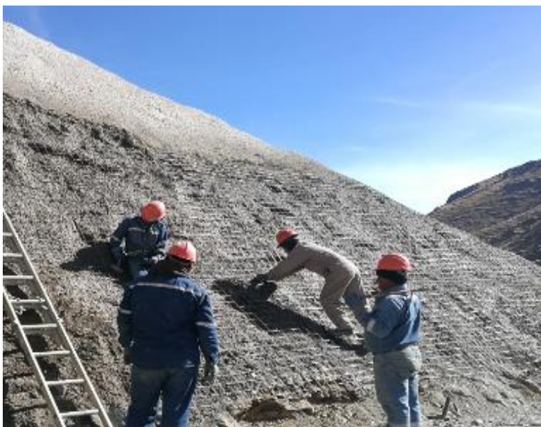
Colocado de malla electrosoldada cotas 3715 a 3705.
