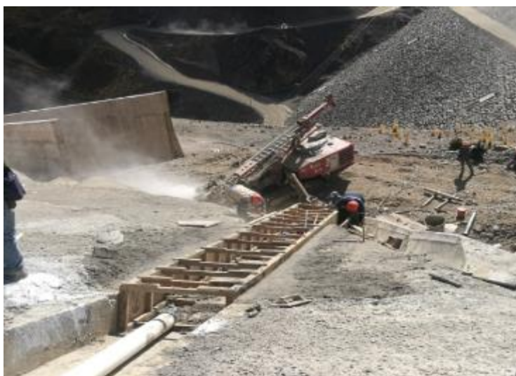
Hormigonado bajante eje 5
