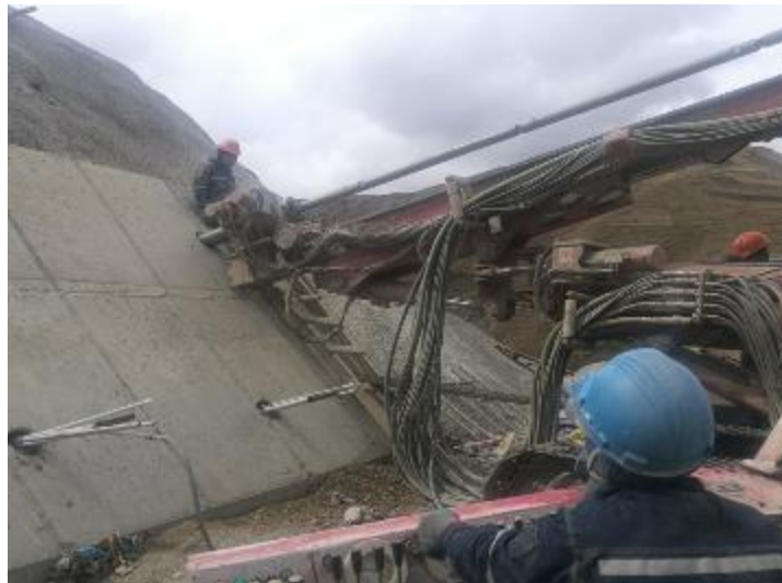
Perforacion barras Williams pantalla cota 3802.00
