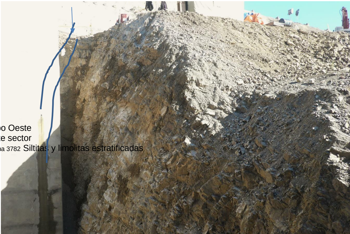
Foto N° 3 Segunda falla longitudinal ubicada al Este de la falla milonitizada
