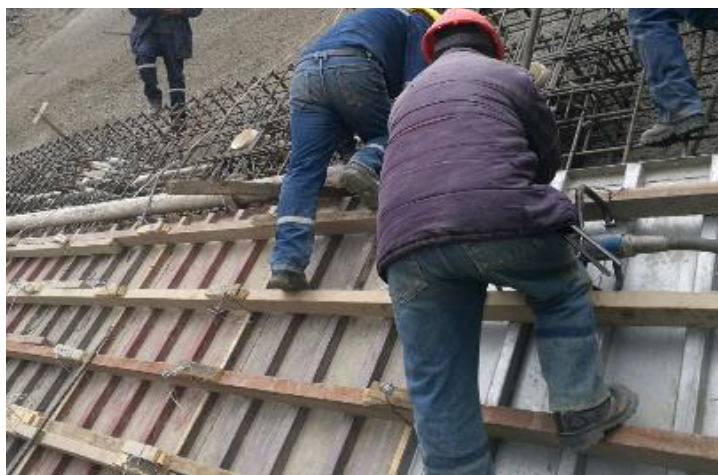
Colocado de hormigón pantalla cota 3802.00
