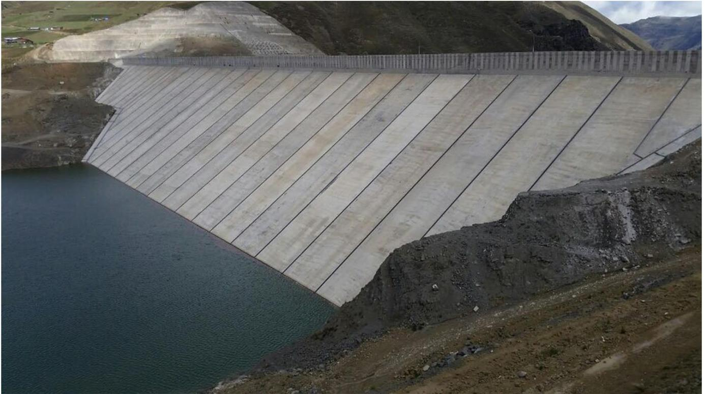
CARA DE CONCRETO Y PARAPETOS, MÓDULOS PREFABRICADOS Y VACIADOS IN SITU
