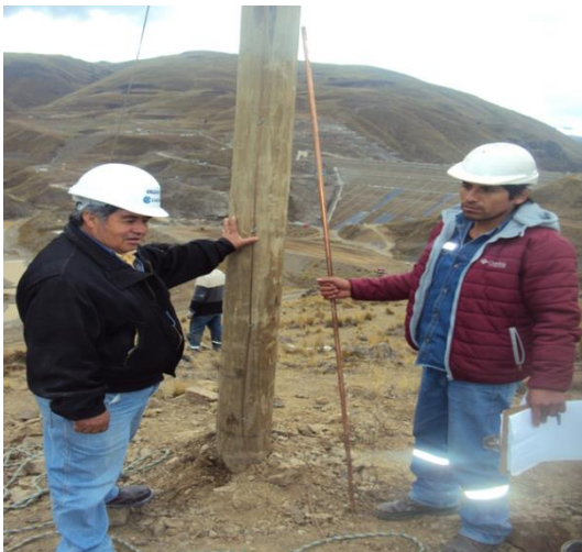
Contratista muestra el uso de barrilla de cobre cuya longitud es de 2,40 metros para uso del sistema de protección a tierra a instalarse en cada poste.
