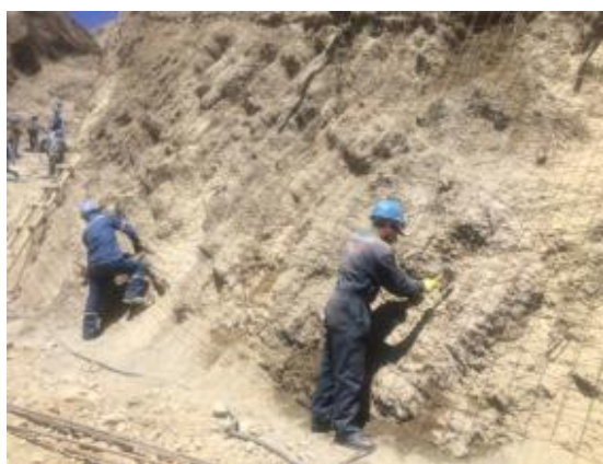
Colocado de malla electrosoldada en talud de aproximación al vertedero y de taludes del vertedero entre cotas 3755 a 3695
