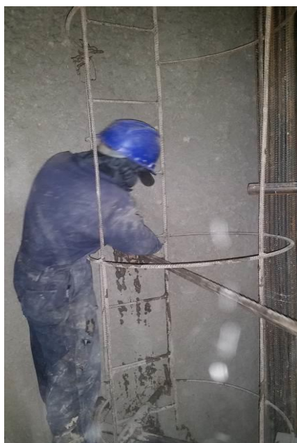
Inyección y Anclaje en diferentes alturas en el Pozo de Compuertas
