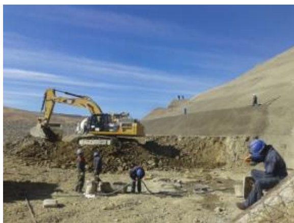
Excavaciones realizadas en el margen izquierdo y en el canal del vertedero
