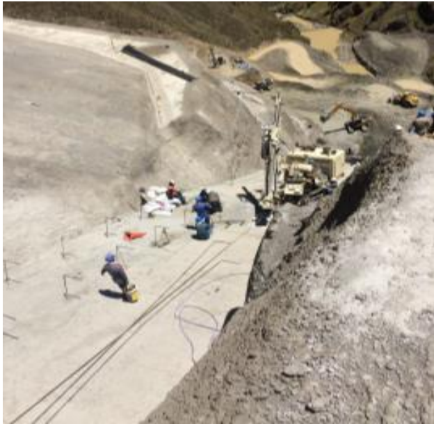
Perforación de anclajes en solera del vertedero Prog. 0+246.85 a 0+290.00
