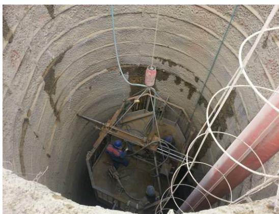
Perforación para Inyección y Anclaje, diferentes alturas en Pozo de Compuertas
