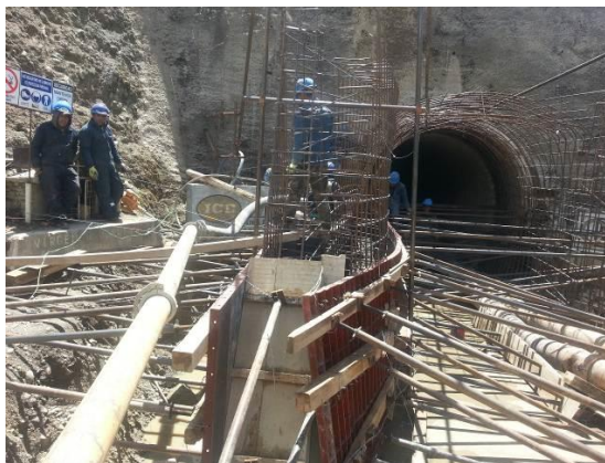
Colocado de Hormigón Tipo "L" primera elevación, muro lado izquierdo, en el ingreso al Túnel de Tránsito.
