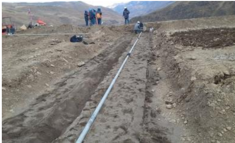
Figura 02. Tendido de tuberías e instalación celda de asentamiento mecánica CR-15.
