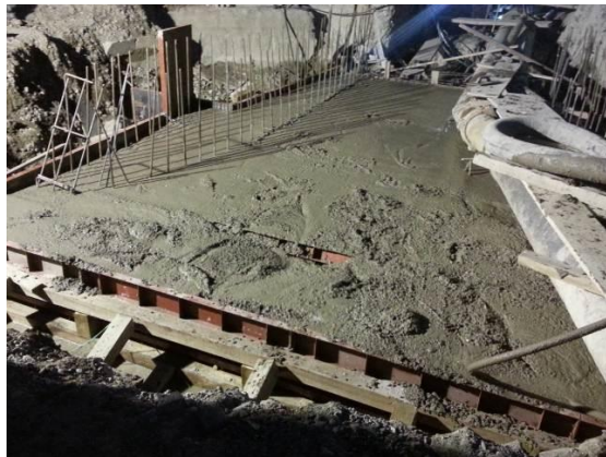
Colocado de Hormigón Tipo "L" en la Losa de ingreso al Túnel de Traslase.
