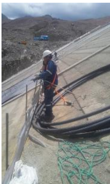
Figura 12. Instalación politubo HDPE MM-02 subiendo sobre la cara del estrudado.
