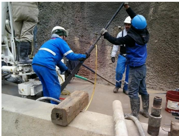
Colocación del Packer
