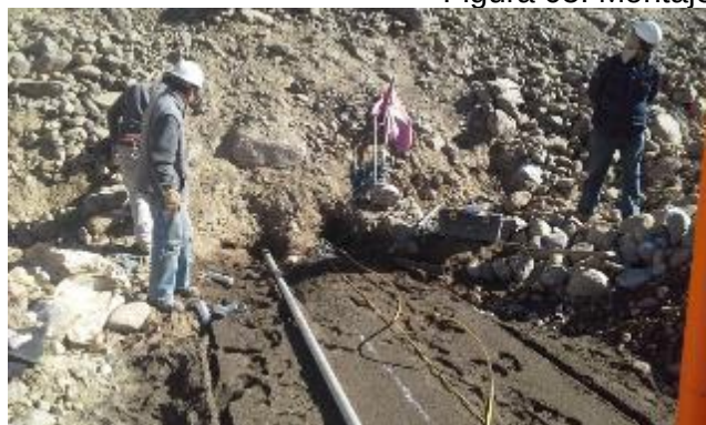
Figura 06. Extendido de cables correspondientes a los instrumentos CR-20* y EM-14.
