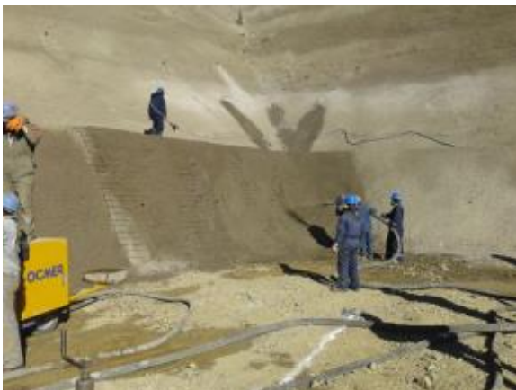
Colocado de hormigón proyectado en talud de aproximación al vertedero y de banquetas entre cotas 3755 a 3695
