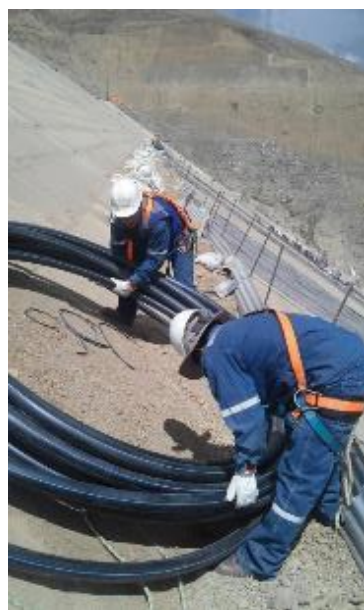
Figura 12. Instalación politubo HDPE MM-02 subiendo sobre la cara del estrudado.
