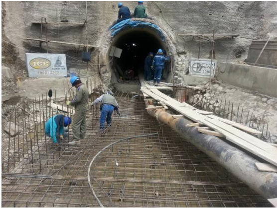
Colocado de armadura de refuerzo en la solera de ingreso al Túnel de Traslase.
