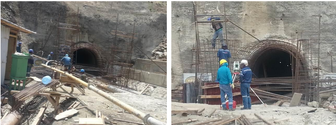
Colocado de armadura de refuerzo en los muros y bóveda de ingreso al Túnel de Trasvase.
