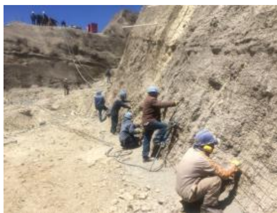
Colocado de malla electrosoldada en talud de aproximación al vertedero y de taludes del vertedero entre cotas 3755 a 3695
