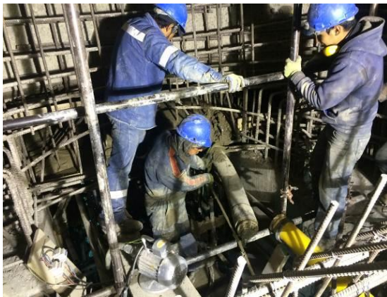
Colocado de Hormigón Tipo "G" en el Pozo de Compuertas
