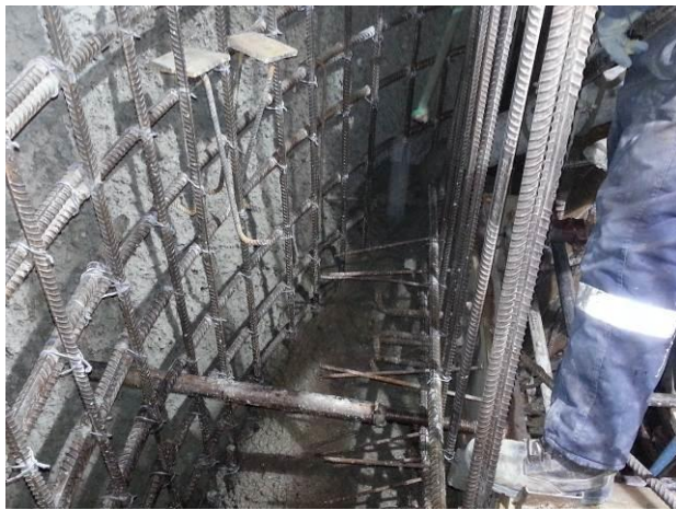
Colocado de Hormigón Tipo "K" en las paredes del Pozo de Compuertas.
