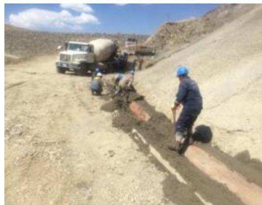
Hormigonado de cuneta margen izquierdo entre cotas 3745 a 3705
