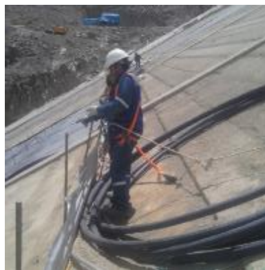
Figura 10. Tubería definitiva MM-01 subiendo sobre la cara del estrudado.
