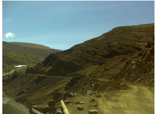
En este sector que comprende los piquetes 36 al 44 se empleara explosivos por ser un sector rocoso, para la excavación de los postes cuya profundidad requerida es de 1,40 metros
