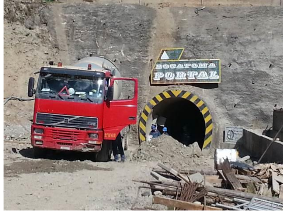
Colocado de Hormigón Tipo "O" en la solera de regularización, en el ingreso al Túnel de Traslase.
