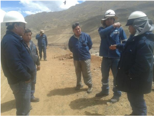
La fotografía muestra al topógrafo de Masicuni explicando las cotas que quedaron por encima del camino en un sector
