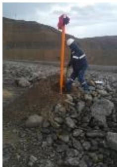
Figura 11. Control topográfico y posterior protección con material 2B del plato de medición colocado sobre medidor magnético de asentamiento MM-03.
