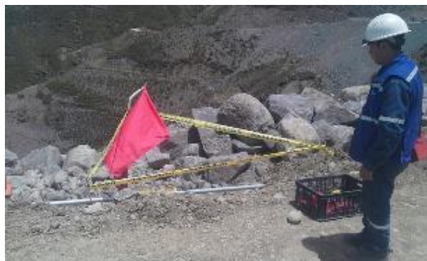
Figura 15. Protección cables de instrumentación correspondiente CL-01 cota 3775,00 hasta el vaciado de la caseta.
