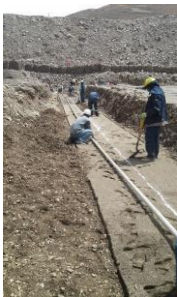
Figura 04. Armado celda mecánica, tuberías y Bloque de concreto celda CR-26.
