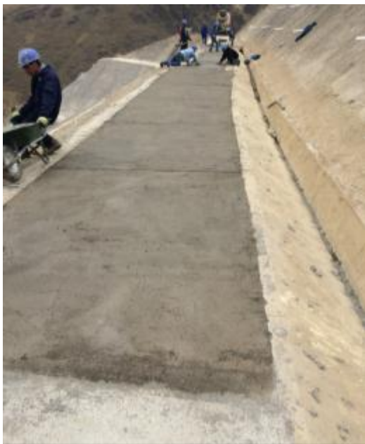
Hormigonado de losa de mortero de cemento en banquetas 3735 y 3725
