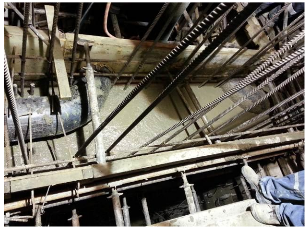
Colocado de Hormigón Tipo "K" en las paredes del Pozo de Compuertas.
