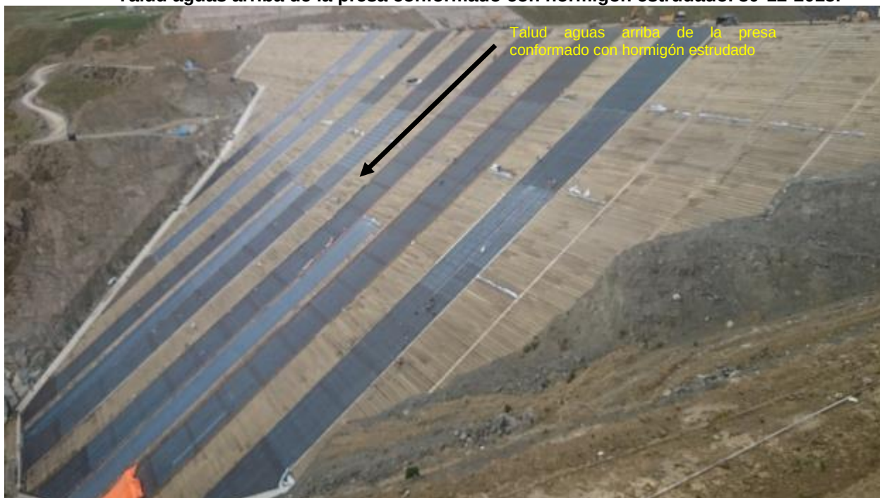
Talud aguas arriba de la presa conformado con hormigón estrudado. 30-12-2015.
