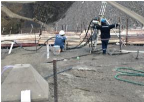
Perforado y colocado de tirantes entre ejes 5 y 6
