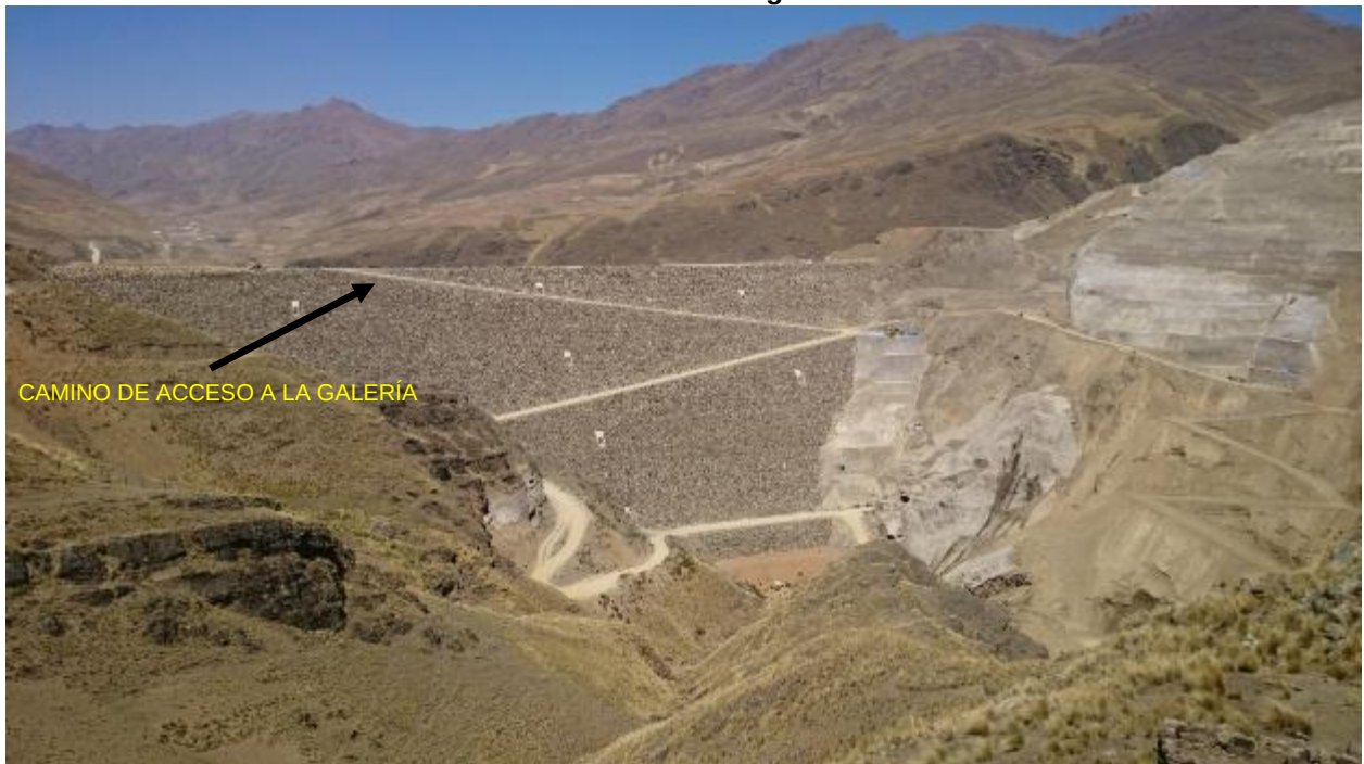
Camino de acceso a la galería. 30-08-2015
