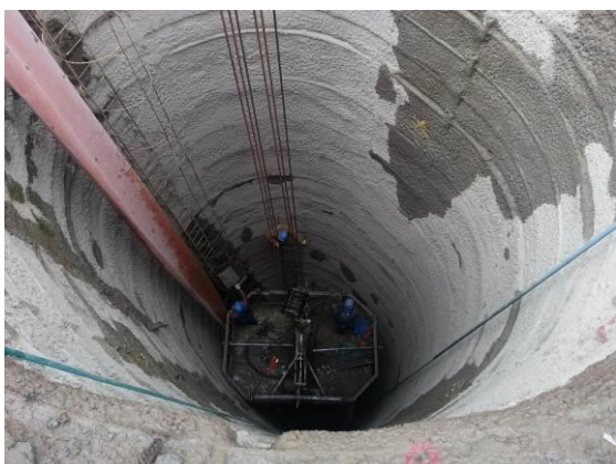
Perforación para Inyección y Anclaje, diferentes alturas en Pozo de Compuertas
