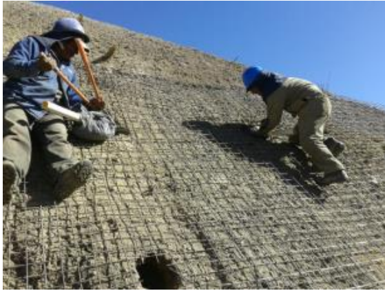
Colocado de malla electrosoldada en talud de aproximación al vertedero y de taludes del vertedero entre cotas 3755 a 3695
