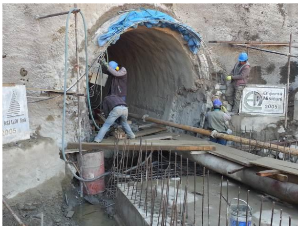
Demolición de la estructura en el ingreso al Túnel de Tránsito.
