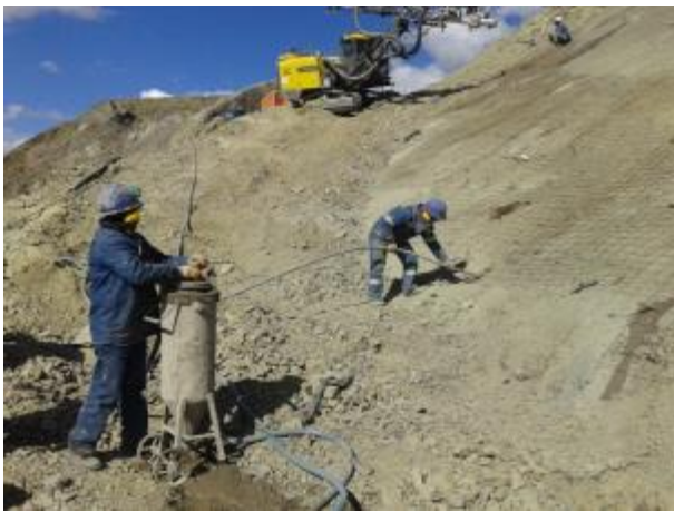
Colocado de pernos tipo A1 en el talud de aproximación del margen izquierdo y en los taludes del canal del vertedero
