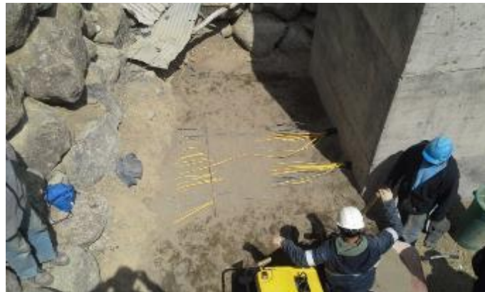
Figura 03. Tendido y conducción de cables a caseta CL-11
