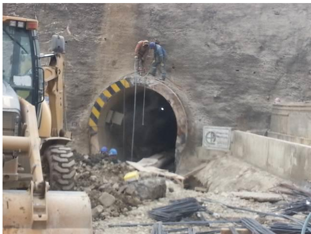
Demolición de la estructura en el ingreso al Túnel de Tránsito.
