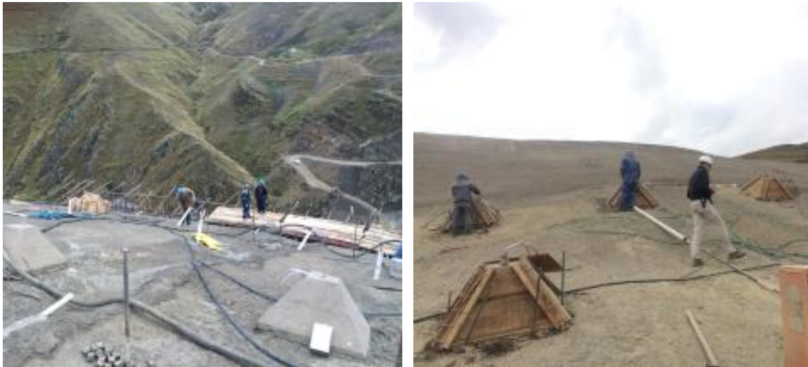
Bloques de anclaje sector tirantes
