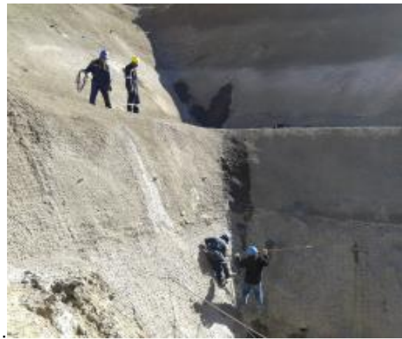
Colocado de pernos tipo A1 en el talud de aproximación del margen izquierdo y en los taludes del canal del vertedero
