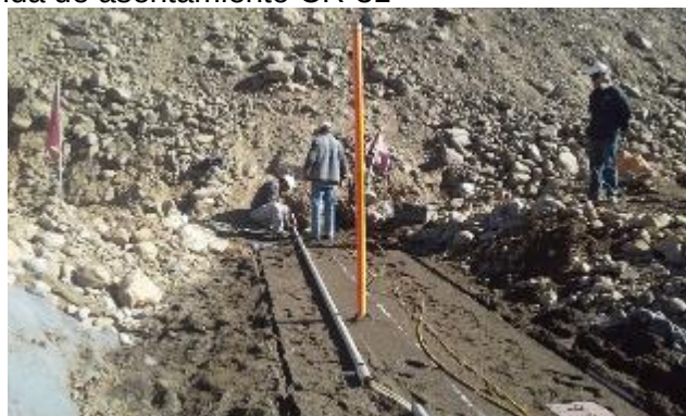
Figura 06. Extendido de cables correspondientes a los instrumentos CR-20* y EM-14.
