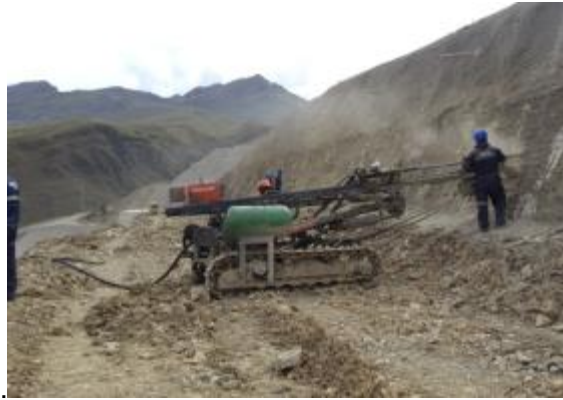
Colocado de Drenes Horizontales Profundos en talud entre banquetas 3795 a 3785
