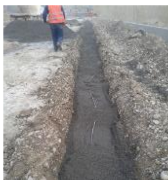
Figura 13. Tendido y cierre de zanjas correspondientes a los piezómetros de cuerda vibrante.
