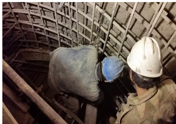
Colocado de Hormigón Tipo "G" en la parte baja del Pozo de Compuertas
