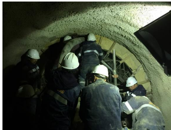
Colocado de Hormigón Tipo "G" en el Pozo de Compuertas
