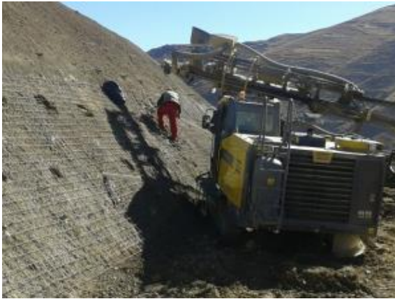
Colocado de Drenes Horizontales Profundos en talud entre banquetas 3795 a 3785
