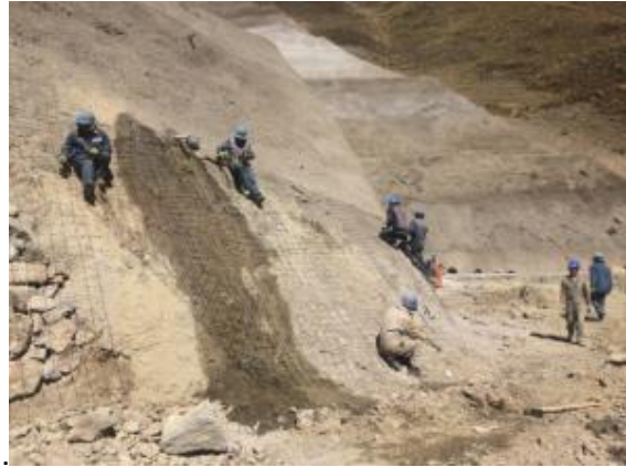
Colocado de malla electrosoldada en talud de aproximación al vertedero y de taludes del vertedero entre cotas 3755 a 3695
