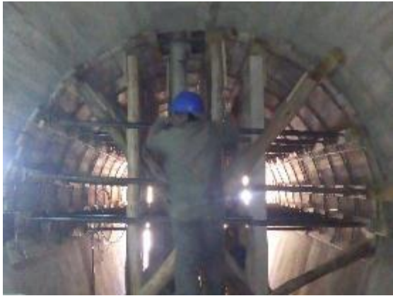
Colocado de Hormigón Tipo "H" en Galería de Acceso
