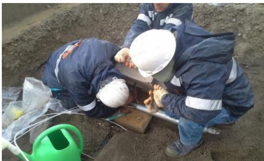
Figura 05. Montaje celda de asentamiento CR-31
