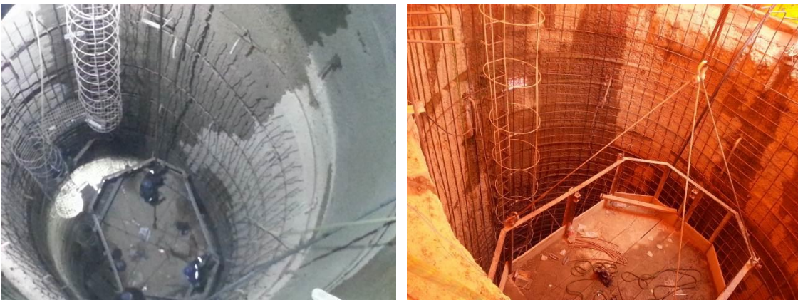
Colocado de armadura de refuerzo en la cara externa del Pozo de Compuertas.
