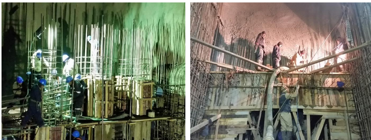
Colocado de Hormigón Tipo "H" en el Portal de Entrada y Cámara de Válvulas del Túnel de Desvío.
