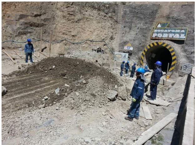
Excavación en la parte externa del Túnel de Traslase.
