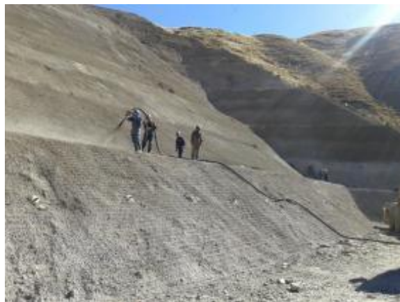
Colocado de hormigón proyectado en talud de aproximación al vertedero y de banquetas entre cotas 3755 a 3695
