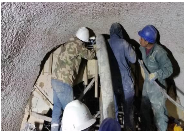
Colocado de Hormigón Tipo "G" en la parte baja del Pozo de Compuertas
