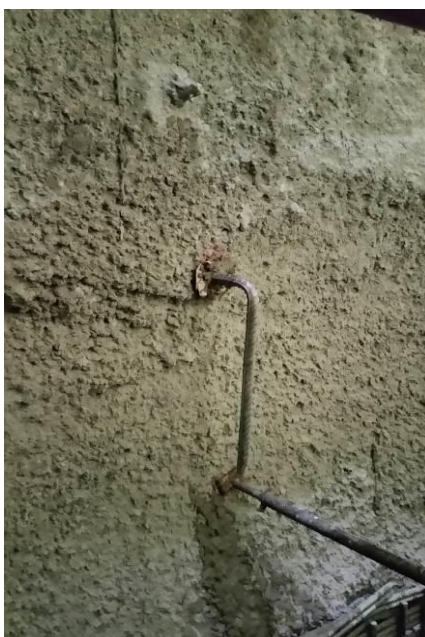
Inyección y Anclaje en diferentes alturas en el Pozo de Compuertas
