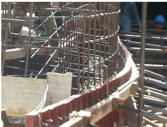
Colocado de Hormigón Tipo "L" primera elevación, muro lado izquierdo, en el ingreso al Túnel de Tránsito.
