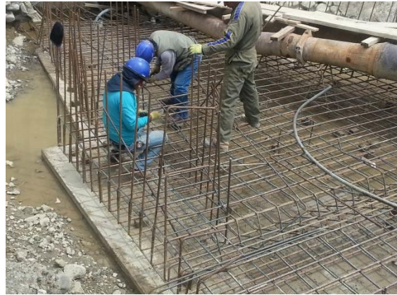
Colocado de armadura de refuerzo en la solera de ingreso al Túnel de Traslase.
