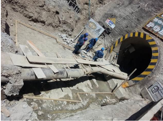
Colocado de Hormigón Tipo "O" en la solera de regularización, en el ingreso al Túnel de Traslase.
