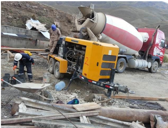
Colocado de Hormigón Tipo "L" en la Losa de ingreso al Túnel de Traslase.
