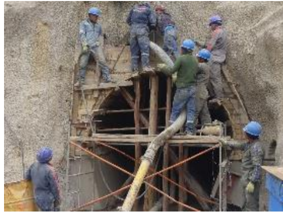
Colocado de Hormigón Tipo "H" en Galería de Acceso
