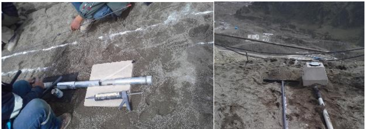
Figura 14. Instalación extensómetro EM-15 y celda de asentamiento hidráulica CR-21 correspondiente caseta CL-02 cota 3775,00.
