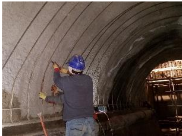
Colocado de Acero de Refuerzo en Galería de Acceso.
