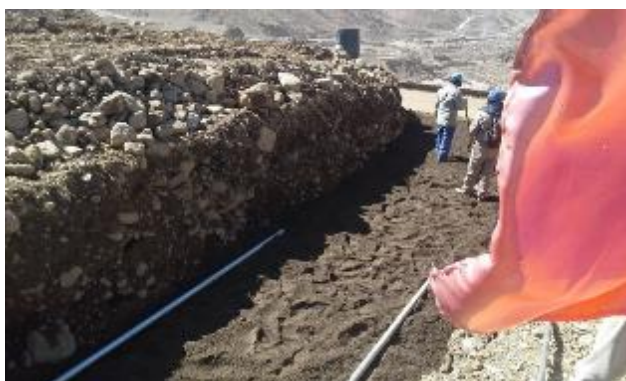
Figura 07. Preparado de los materiales 2B y F para el extendido de los cables.
