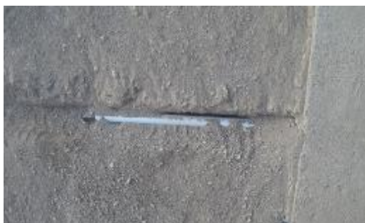
Figura 09. Excavación y colocado de las tuberías de conducción de cables medidores de junta.
