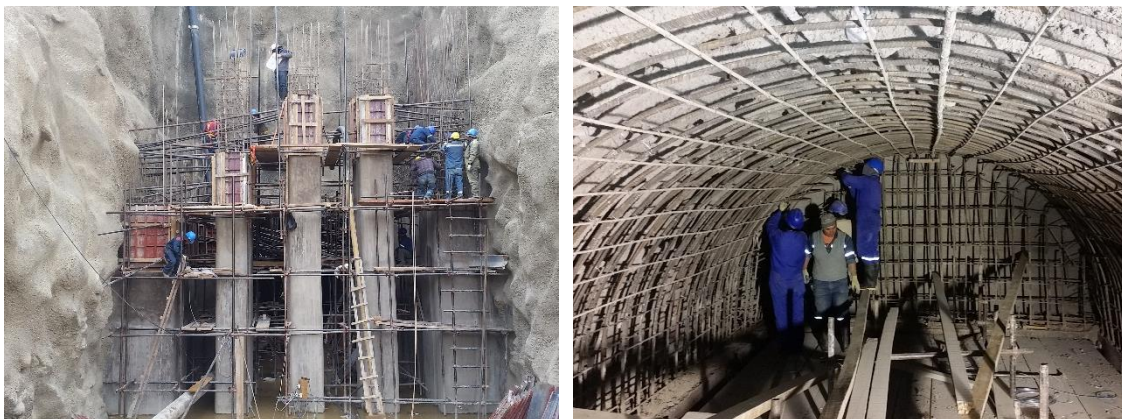
Colocado de acero de refuerzo en el sector del Portal de Entrada y la Cámara de Válvulas.
