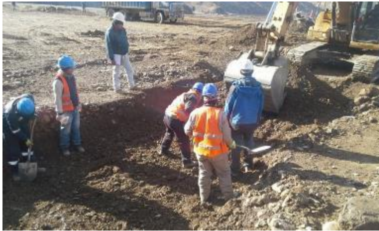
Figura 01. Excavación zanja de instrumentación CL-08.
