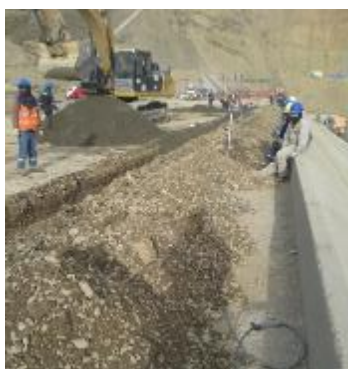
Figura 13. Tendido y cierre de zanjas correspondientes a los piezómetros de cuerda vibrante.
