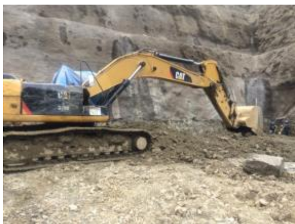
Excavaciones realizadas en el margen izquierdo y en el canal del vertedero
