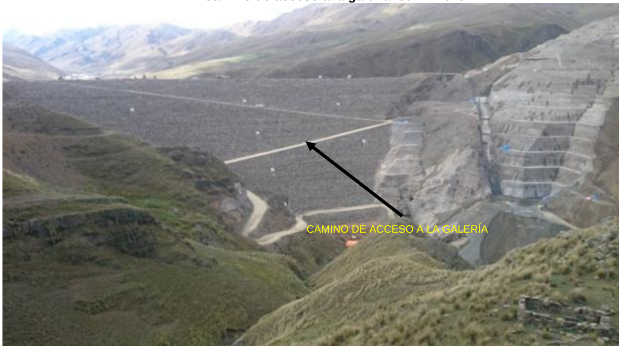
Camino de acceso a la galería. 30-12-2015
