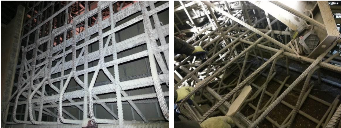
Colocado de armadura de fierro en el sector del Pozo de Compuertas
