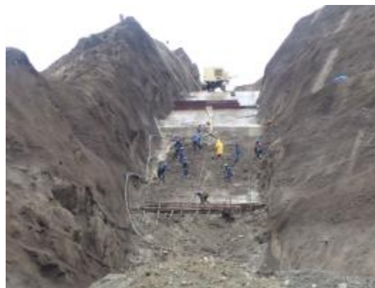
Vaciado de hormigón de regularización tipo O presolera canal del vertedero
