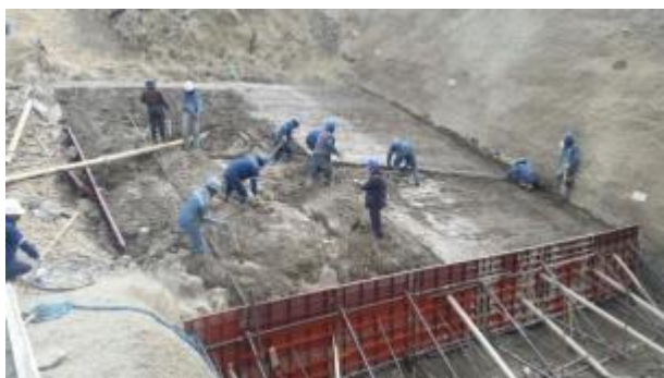
Vaciado de hormigón de regularización tipo O presolera canal del vertedero
