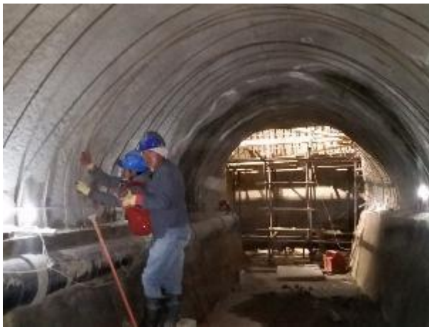
Colocado de Acero de Refuerzo en Galería de Acceso.
